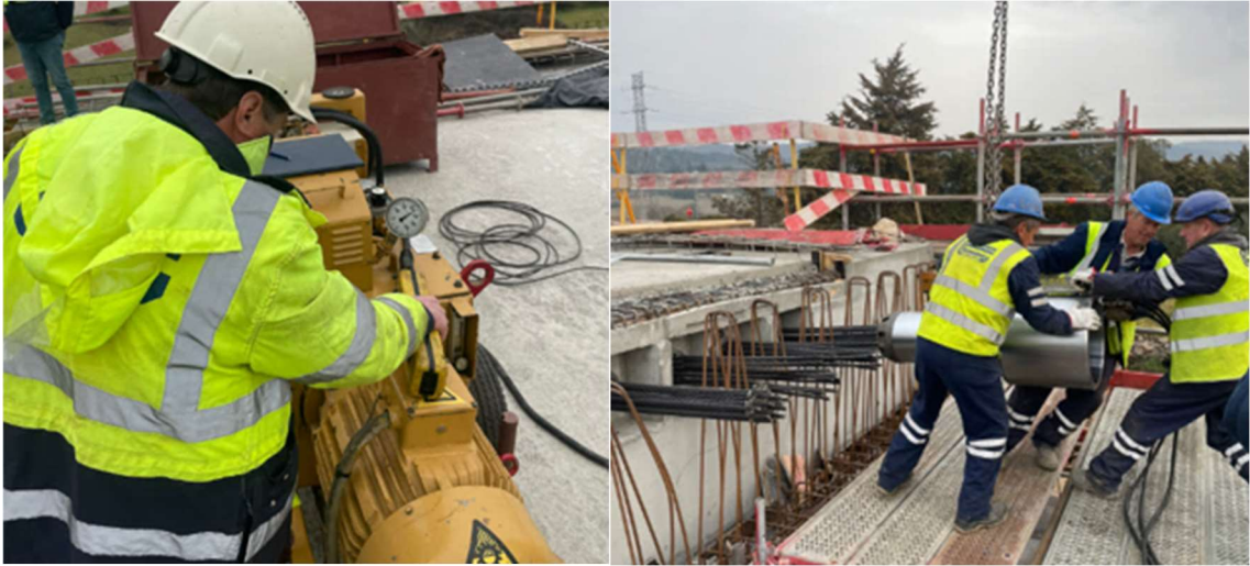
Figura 1.16. – Tensionamento de pré-esforço de um dos cabos da nervura do extradorso
