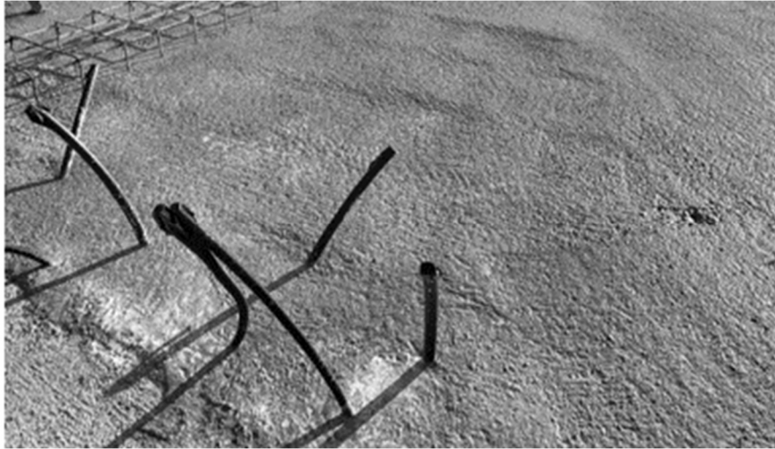
Figura 1.15. –Tubo de purga após a betonagem da terceira fase do tabuleiro
