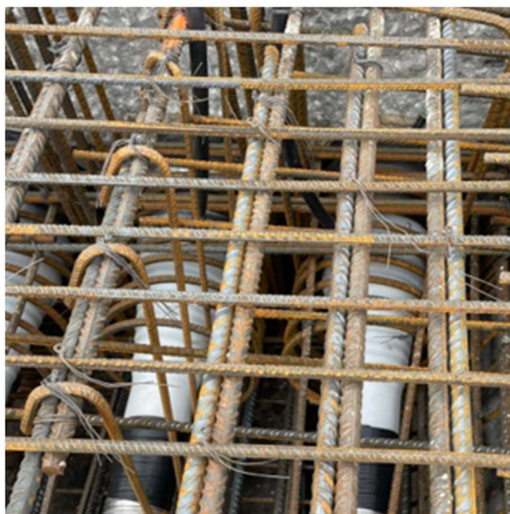
Figura 1.12. – Armaduras ordinárias nas zonas de ancoragem antes da betonagem do tabuleiro
