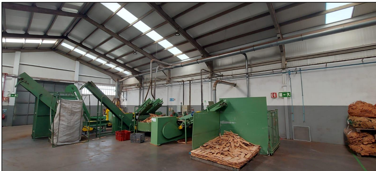
Figura 14- Máquinas de serrar, desbarrigar e despaldar (sequencialmente da esquerda para a direita)
