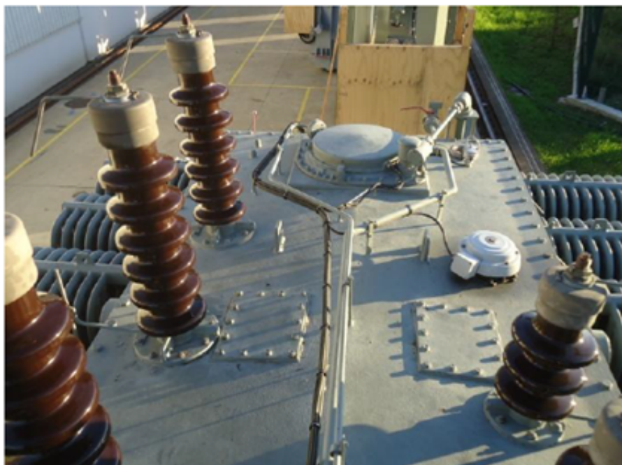
Figura 2.4: Travessias do Transformador
