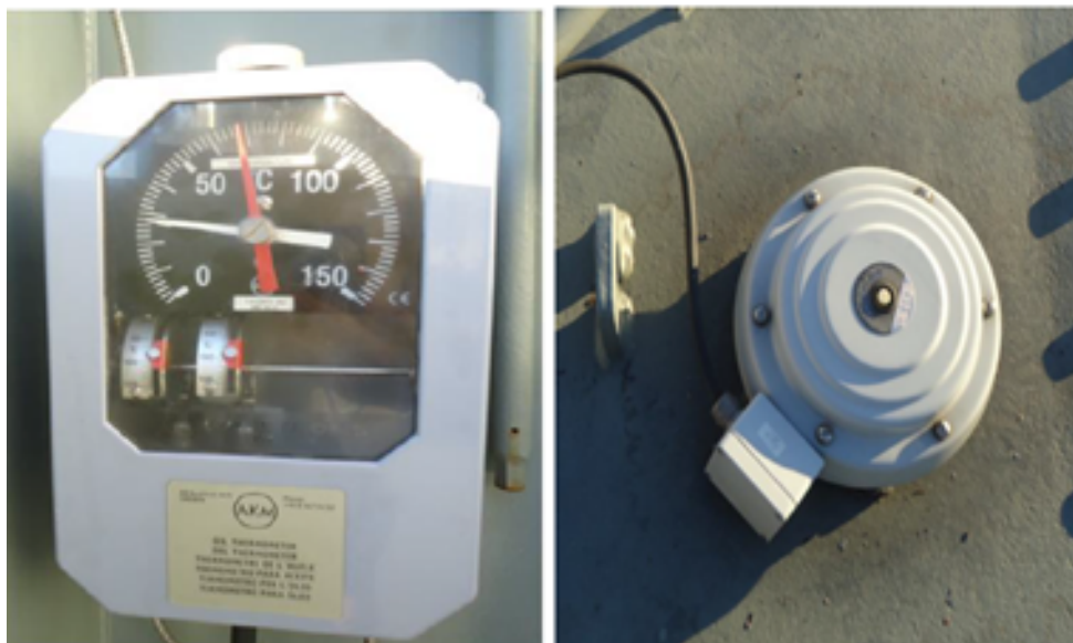
Figura 2.6: Termómetro e Válvula de Sobrepressão
