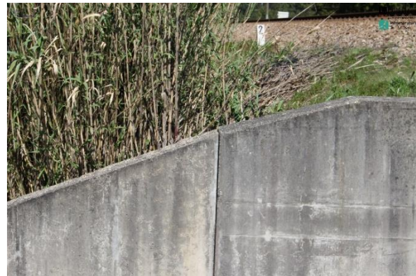
Figura 3.5 – Juntas de dilatação da ponte de Sangalhos
