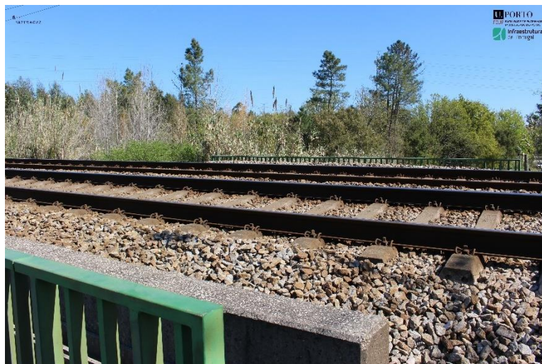
Figura 3.6 – Pormenor das travessas e dos carris da ponte de Sangalhos
