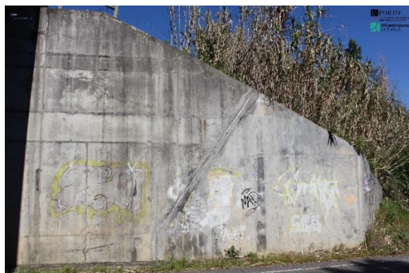
Figura 3.5 – Juntas de dilatação da ponte de Sangalhos
