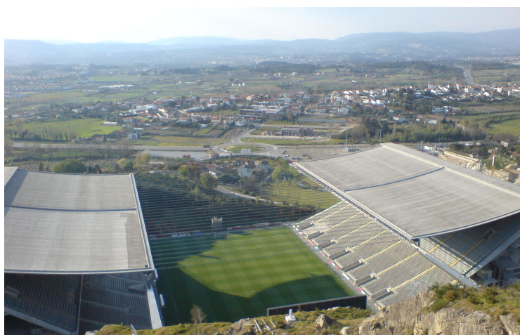
Figura 4: Estádio Municipal de Braga
