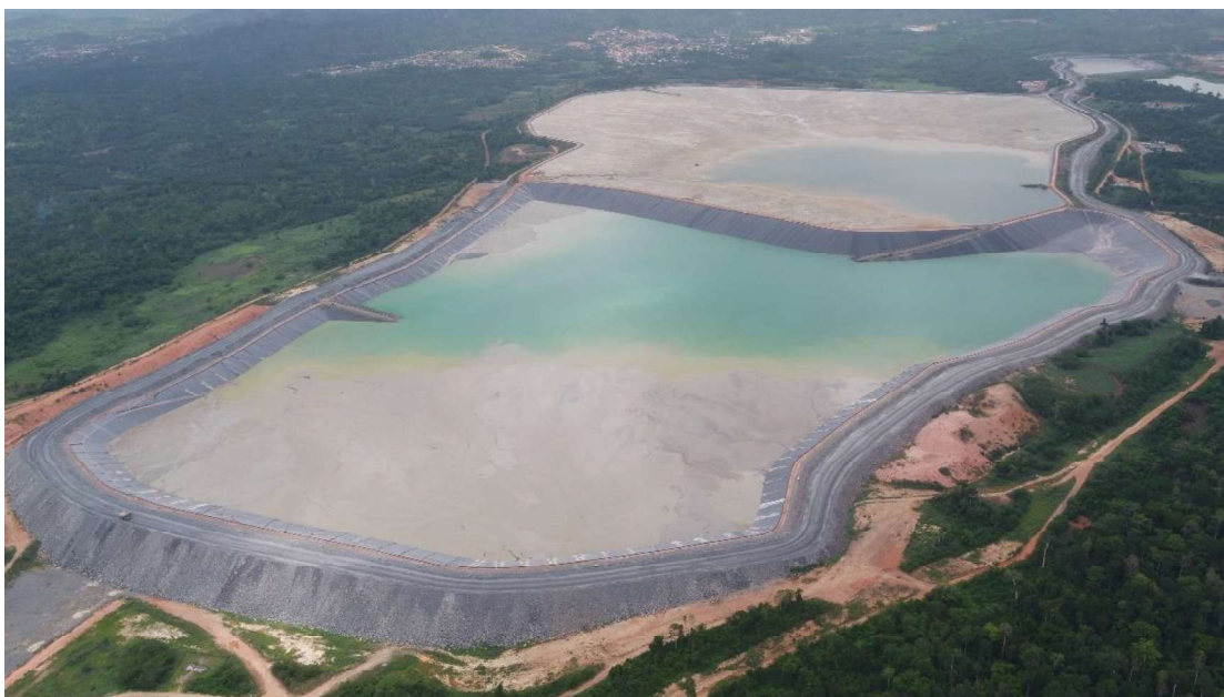
Figura 4 – Barragem de Rejeitados da Mina de Akyem no Gana, [1]
