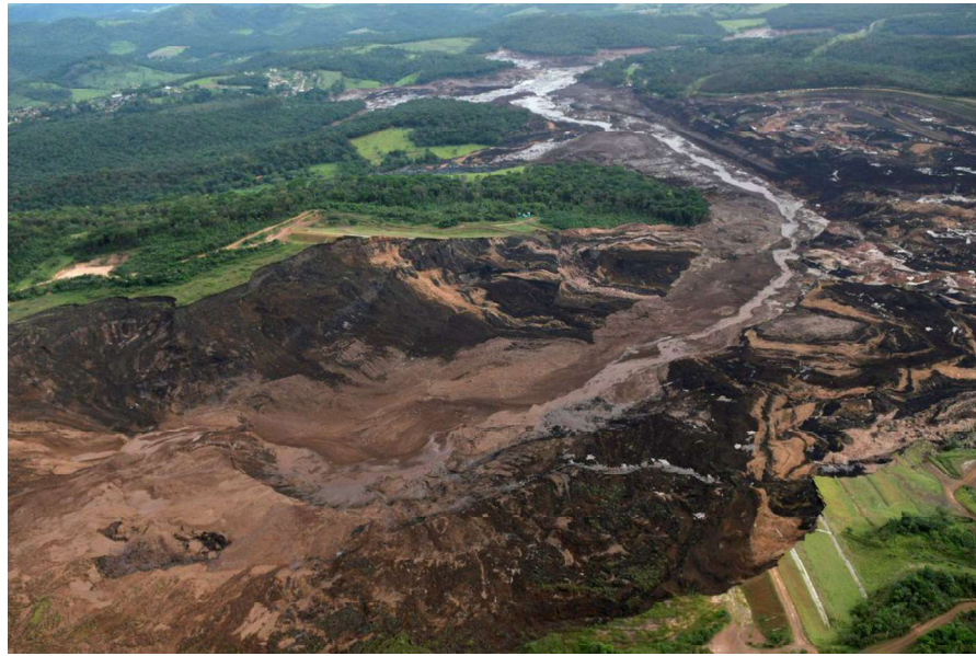
Figura 5 – Desastre da Barragem de Rejeitados de Brumadinho, REUTERS/Washington Alves
