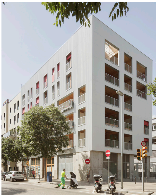
Img. 70 Fotografia do exterior do projeto, vista da rua
