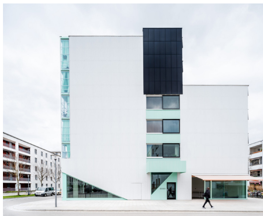
Img. 84 Fotografia do exterior do topo do edifício
