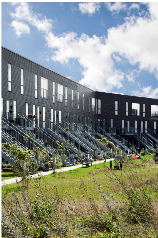
Img. 24 Fotografia da Fachada exterior
