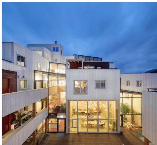
Img. 56 Fotografia do pátio central
