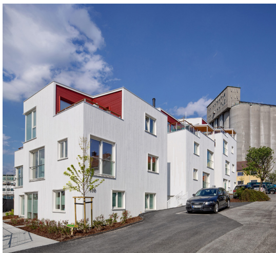
Img. 55 Fotografia do exterior do edifício, vista da rua
