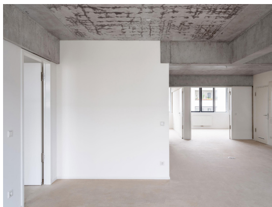
Img. 91 Fotografia do interior de um fogo
