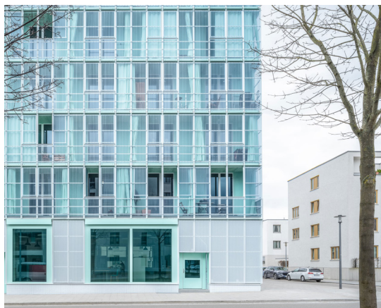
Img. 83 Fotografia do exterior do edifício
