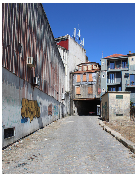
Img. 141 Fotografia da entrada do lote, vista do interior do terreno
