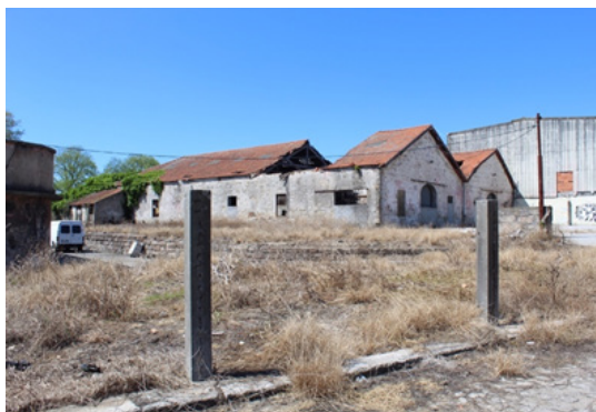
Img. 158 Fotografia da construção mais a norte no terreno
