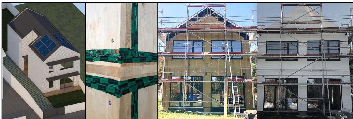
Fig. 2.20 – Evolução da construção da Casa do Carril: Projeto; Ligações metálicas e fita isoladora; Aplicação do Isolamento térmico; Aplicação dos Revestimentos [21]
