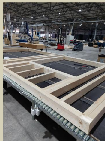
Figura 42 – Execução da estrutura em madeira
