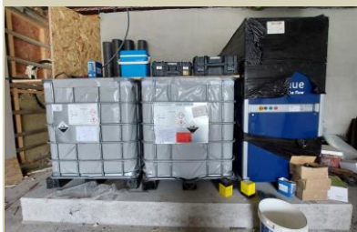
Figura 35 – Sistema de armazenamento de vanádio
