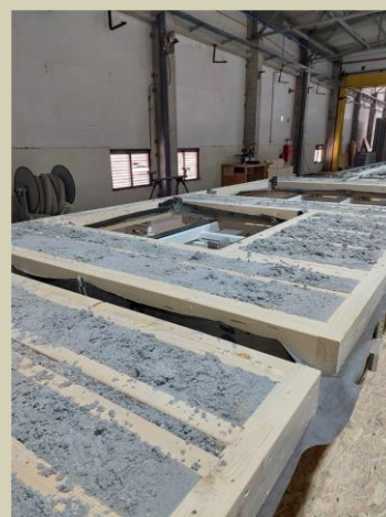
Figura 43 – Insuflação de celulose como isolamento térmico da estrutura
