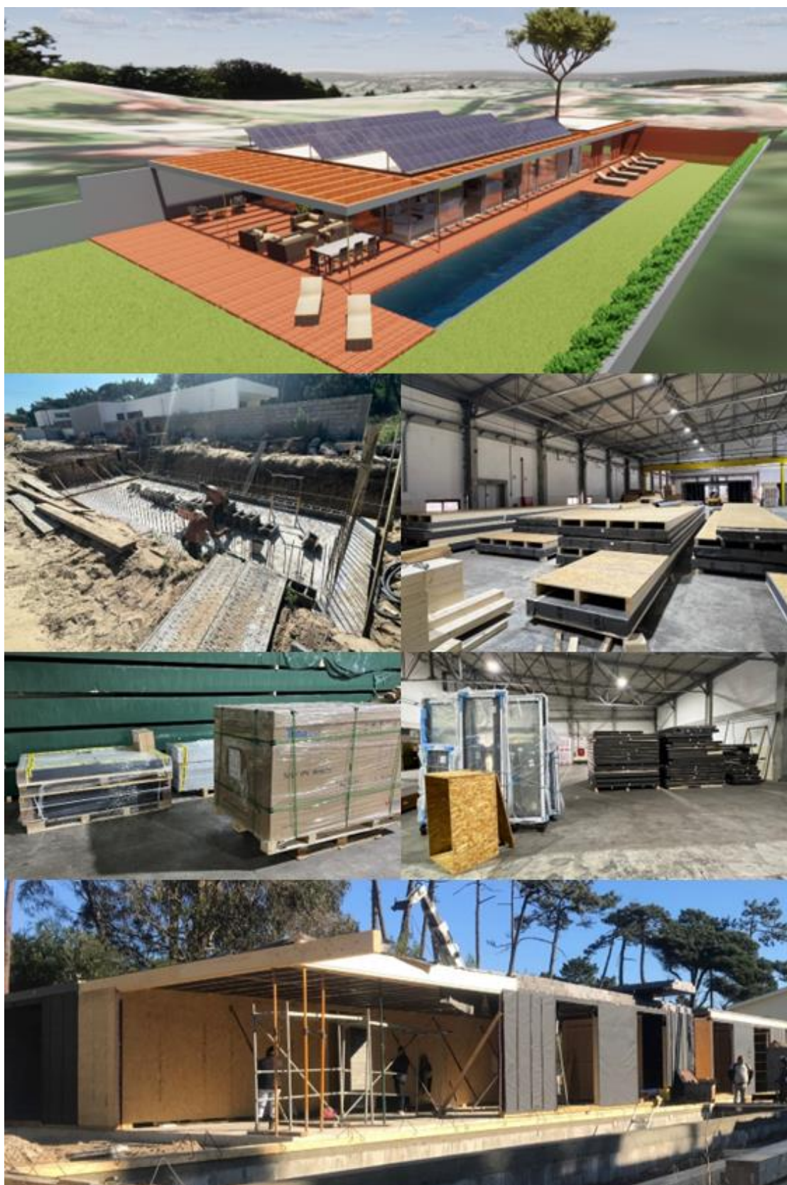
Figura 4 2 – Esquema 3D da Casa Protótipo, estruturas em construção em estaleiro e obras no terreno
