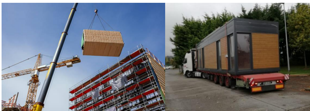
Figura 2.10 – Acoplagem e Transporte do Módulo [20, 21]
