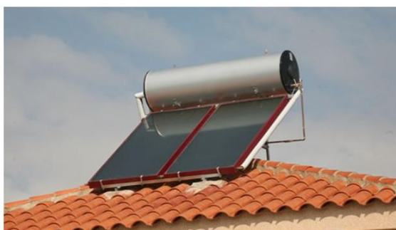
Figura 3.22 – Sistema de termossifão [62, 63]
