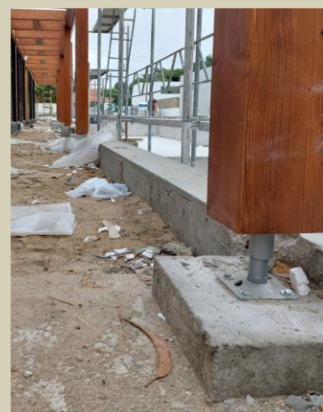
Figura 56 – Sistema elevatório da pérgula
