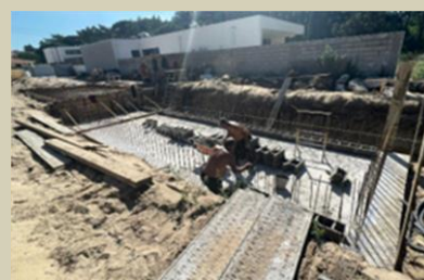
Figura 9 – Execução do ensoleiramento geral
