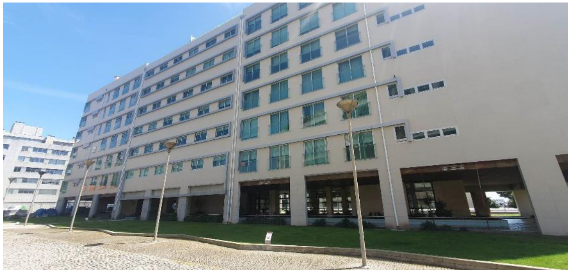
Figura 39 – Fachada orientada a Norte da parede do caso de estudo 2.
