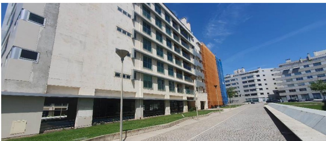
Figura 41 – Fachada orientada a Sul da parede do caso de estudo 2.
