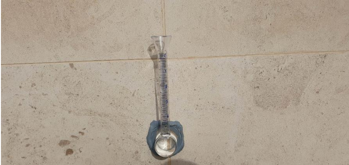
Figura 45 – Representação da colagem do tubo de Karsten no revestimento da fachada (Juntas).
