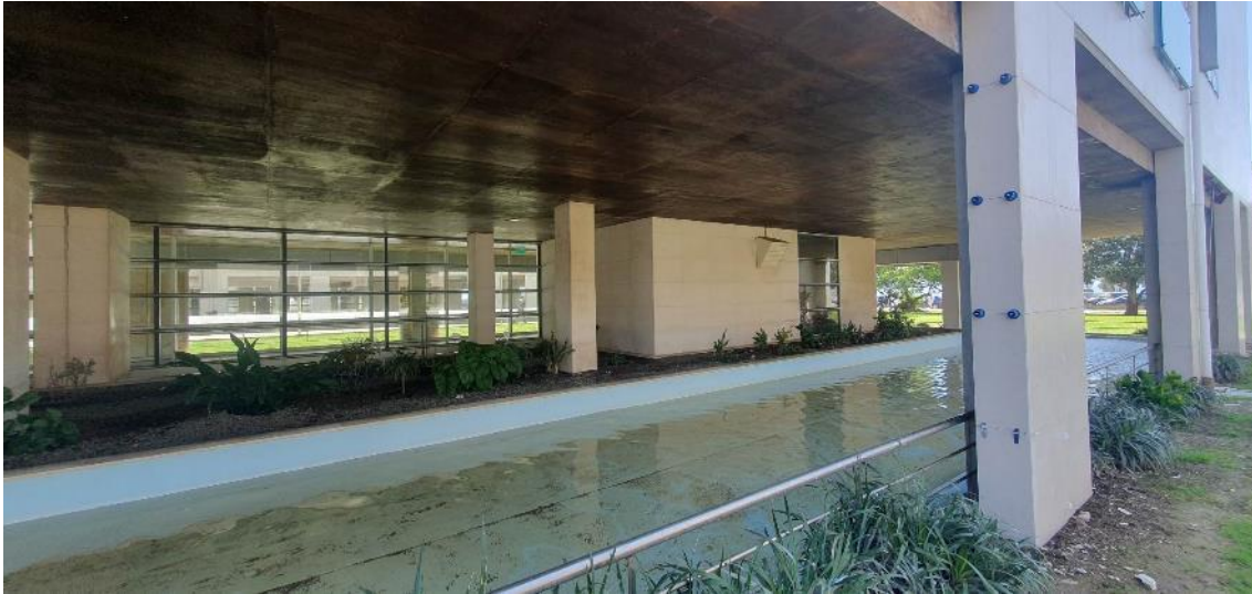
Figura 53 – Imagem identificativa do local resguardado do edifício do caso de estudo 2.
