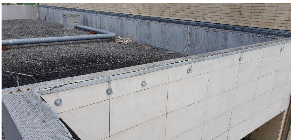
Figura 48 – Representação da colagem dos tubos de Karsten no revestimento da fachada no topo da fachada.
