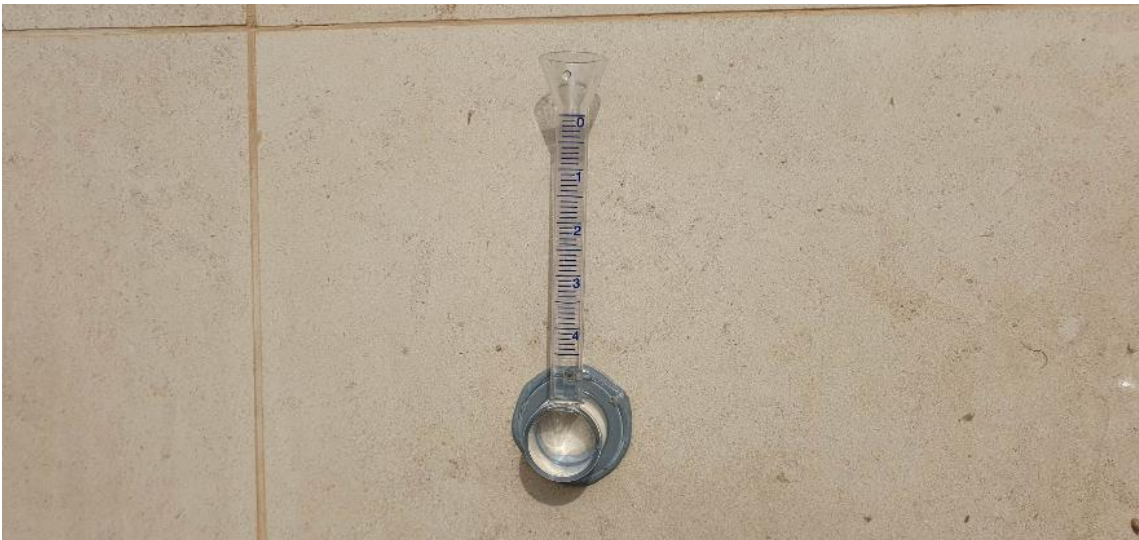
Figura 46 – Representação da colagem dos tubos de Karsten no revestimento da fachada (Seio da pedra).
