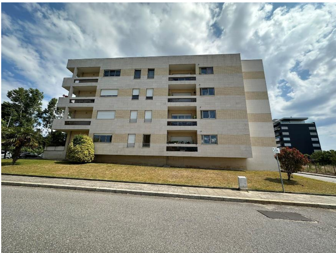
Figura 31 – Fachada orientada a Sul da parede do caso de estudo 1.
