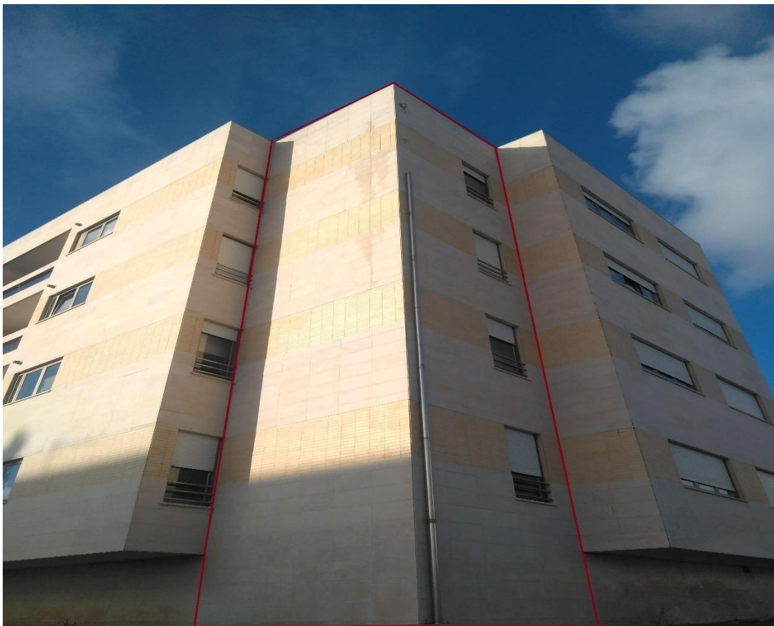
Figura 36 – Delimitação do revestimento de fachada que foi sujeito a reabilitação.
