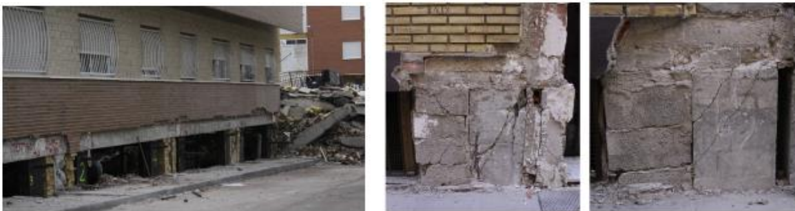
Fig.4.2. - Efeito pilar-curto devido a níveis parciais de garagens e caves (Romão, et al., 2013)
