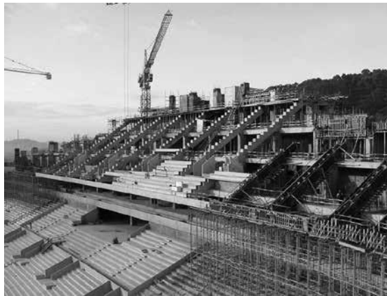
Fig. 2.4 - Aplicação da pré-fabricação na bancada do Estádio do Dragão [20]
