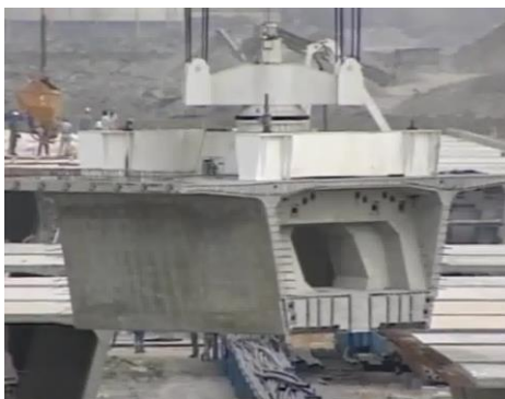
Fig. 2.3 - Vigas pré-fabricadas aplicadas no Viaduto Central [17]
