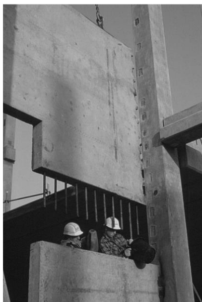
Fig. 2.17 - Ligação entre duas paredes pré-fabricadas [8]
