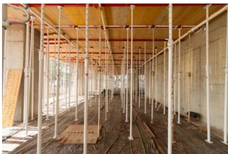
Fig. 2.13 - Sistema de cofragem para laje in situ [28]
