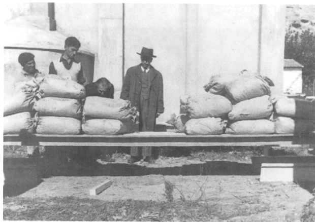
Fig. 2.2 - Prova de carga de uma viga pré-esforçada pré-fabricada [14]
