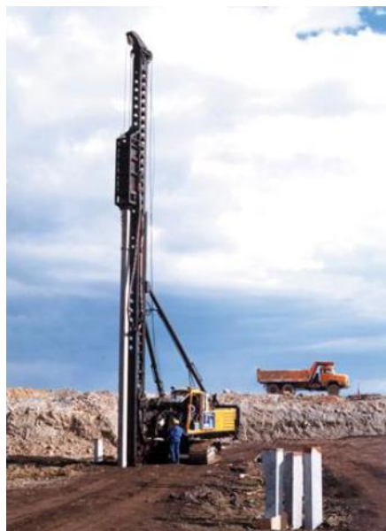
Fig. 2.7 - Cravação de uma estaca pré-fabricada [26]
