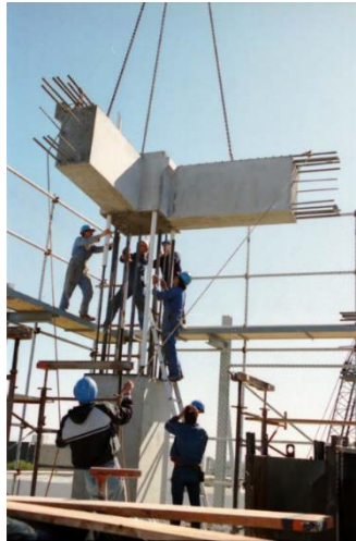
Fig. 2.35 - Ligação viga-viga pré-fabricada [41]
