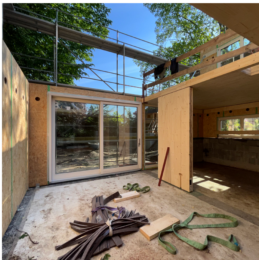
F36. Fotografias do Processo de Construção
