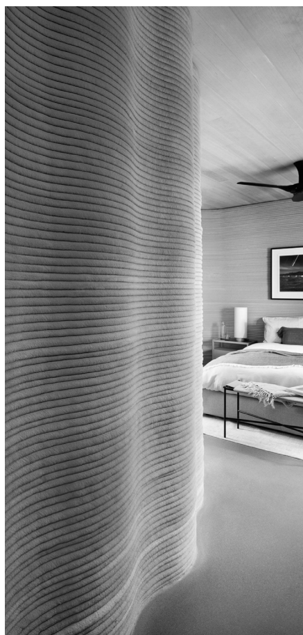
F12. Construção da “House Zero” Estúdio Lake Flato e Empresa ICON (2022)
