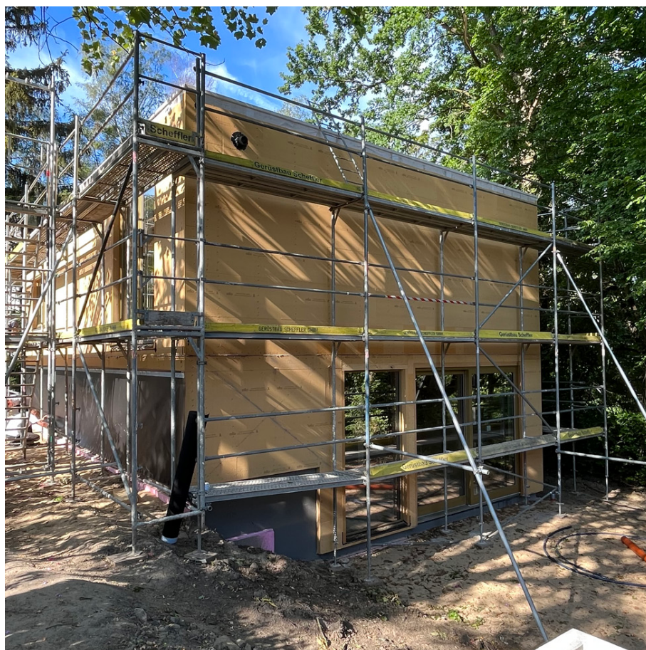
F37. Fotografias do Processo de Construção
