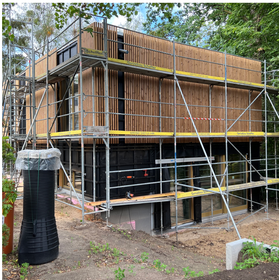
F38. Fotografias do Processo de Construção
