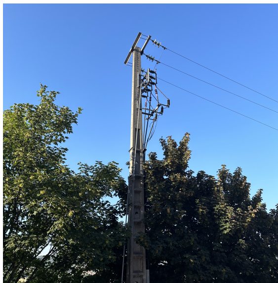
Figura 2.13: Apoio de Fim de Linha
