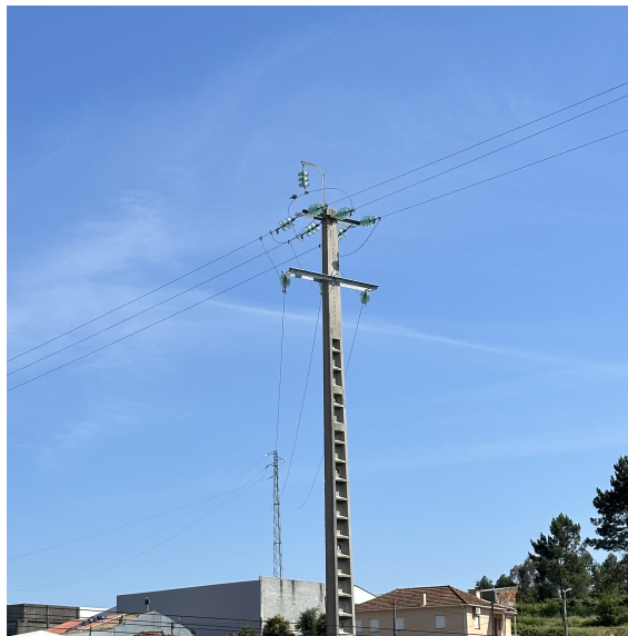
Figura 2.10: Apoio de derivação em alinhamento
