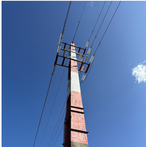
Figura 2.11: Apoio de reforço em alinhamento
