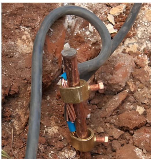
Figura 2.16: Imagem Ilustrativa Eléktodo de Terra [20]
