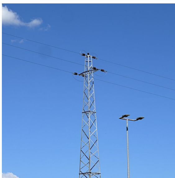
Figura 2.8: Apoio de alinhamento
