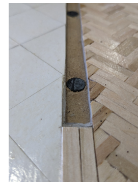
Imagem 123 e 124 | Sistema de fixação de ímãs.
