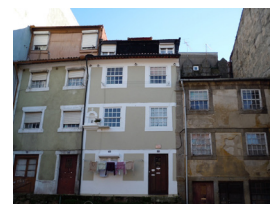
Imagem 8 | Fachada das 3 edificações mencionas.
