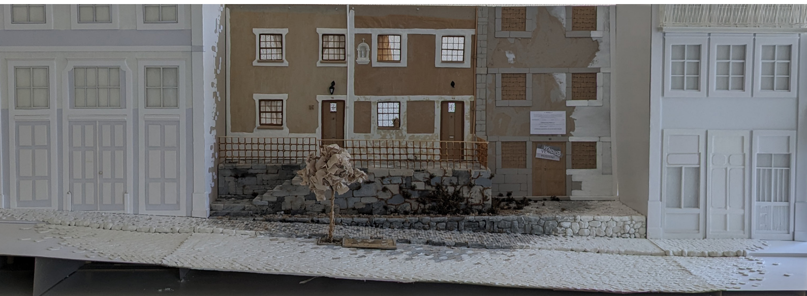
Imagem 130 | Lugar no presente antes de qualquer intervenção.
