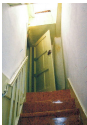
Imagem 10 | Topo da escada.
