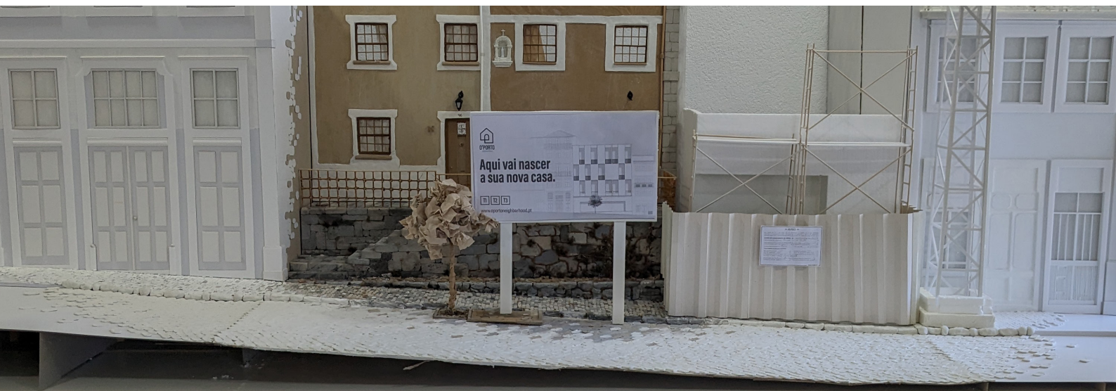
Imagem 133| Segunda fase de obras - construção do Piso térreo, aparecimento do outdoor de promoção da construção.
