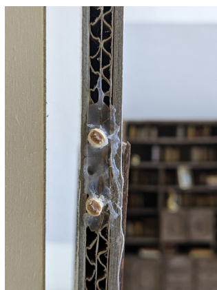
Imagem 120, 121 e 122 | Pormenor de conexão das peças em cola branca, quente e paus de espetada.
