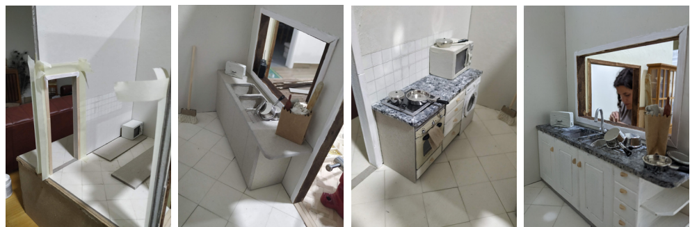
Imagem 101, 102 e 103 | Evolução da construção da cozinha.
