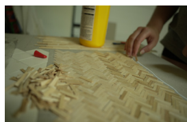
Imagem 113 | Execução do chão da sala de jantar.
