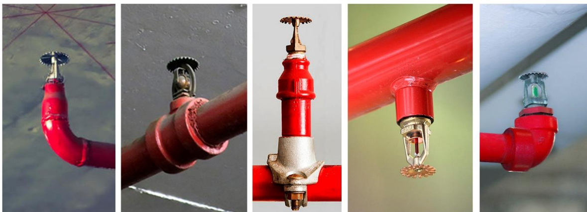
Fig. 29 - Vários tipos de acessórios para conexão de sprinklers à tubagem [44-48].
