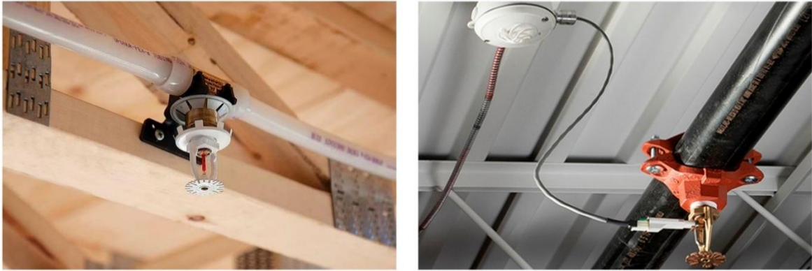
Fig. 17 - Sprinkler polimérico (esq.) e de ativação elétrica (dir.) [35, 36].
