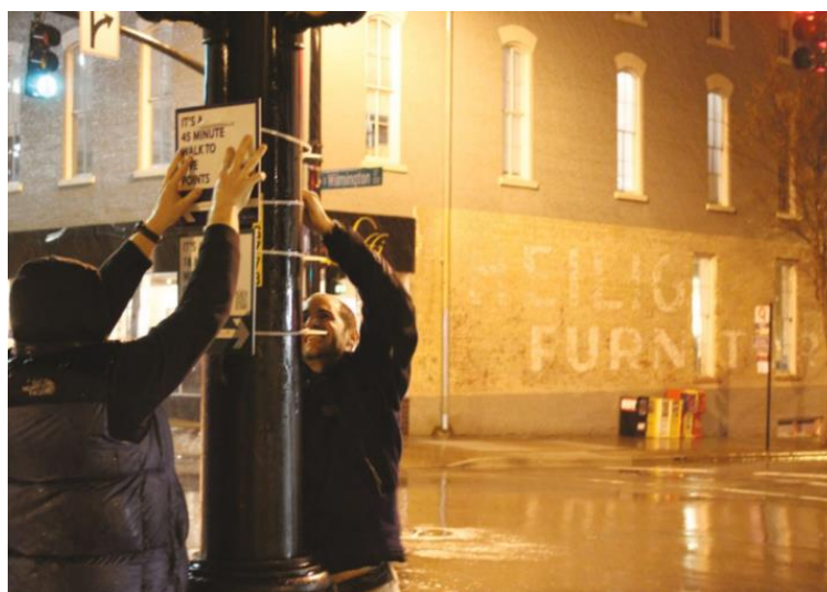
Figura 18: Matt Tomasulo fixando as placas de sinalização (Lydon & Garcia, 2015).
