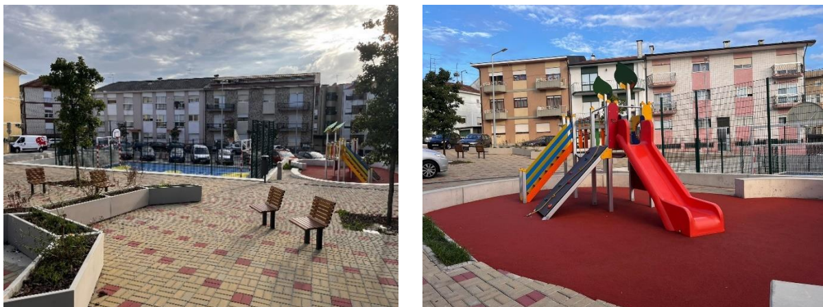
Figura 29: Praceta Sá da Bandeira, após intervenção.
