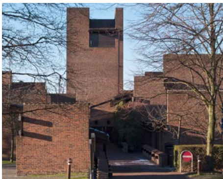
Fig.198 – Igreja Buddinge, Copenhaga – composição totalmente em tijolo, onde os edifícios, muros e pavimentos formam uma paisagem artificial em tijolo
