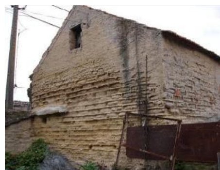
Fig.188 – Casa construída apenas em blocos de adobe – Aveiro
