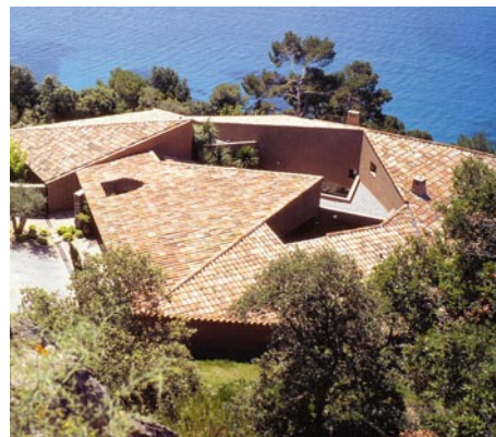
Fig.160 – Telhado composto por telha canudo
