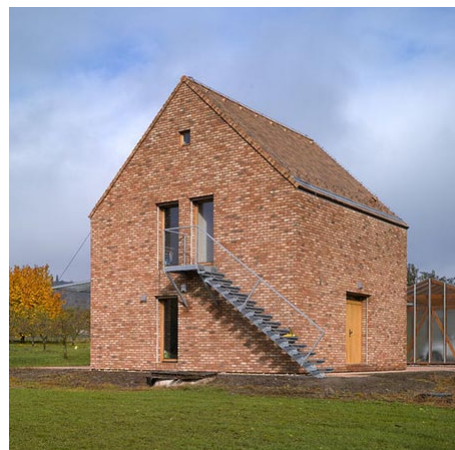
Fig.72- Casa Velisi de David Kraus – utilização do tijolo numa pequena habitação, de forma depurada
