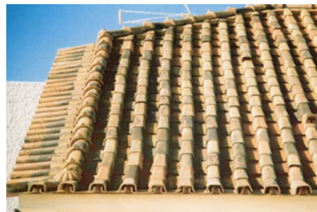
Fig.161 – Telhado composto por telha romana
