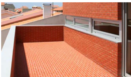
Fig.196 – Alvenaria de tijolo cerâmico
