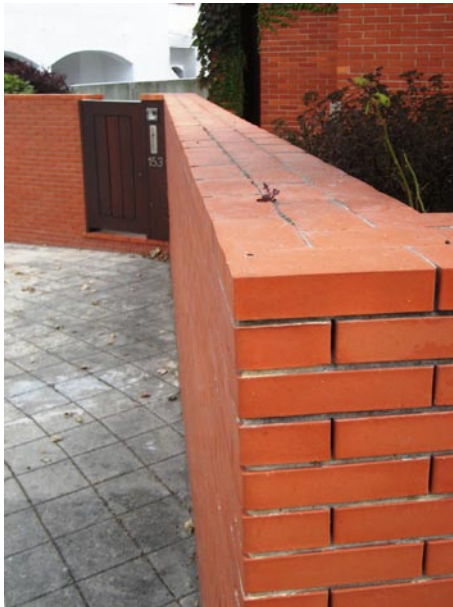
Fig.142 – Muro tradicional, Casa em Matosinhos
