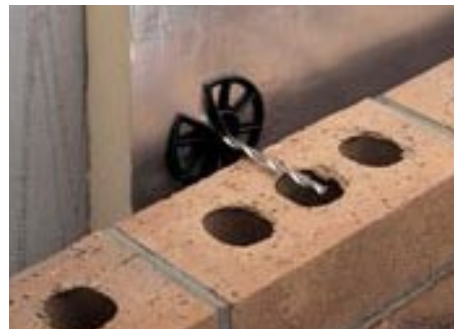
Fig.110 – Utilização dos discos de fixação das placas de isolamento
