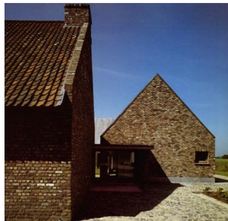
Fig.71 – Quinta em Oudenburg, Bélgica, século XVIII – os edifícios contêm uma robusta expressão rural, dada por paredes em tijolo cerâmico onde se abrem alguns vãos austeros e pelas coberturas de duas águas de acentuadas pendentes revestidas a telha cerâmica. O conjunto possui uma forte e carismática presença, acentuada pela tonalidade dada pelos materiais cerâmicos, que é realçada por uma pigmentação com diversas nuances que lhes acentua o carácter e enfatiza a marca da passagem no tempo
