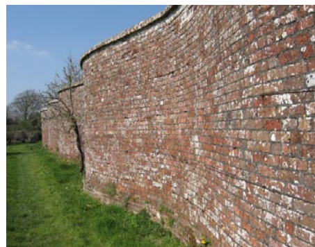
Fig.146 – Muro Serpentina
