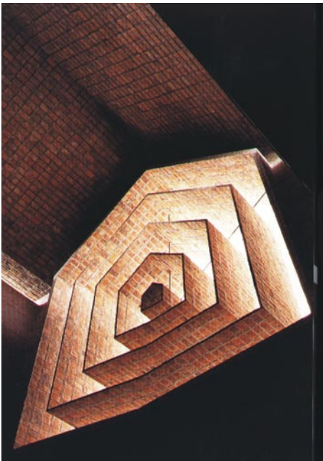
Fig.60 - Igreja de S. Pedro de Durazno, Uruguai, 1968, Eladio Dieste – uma nave que evita os pilares em 32 metros
