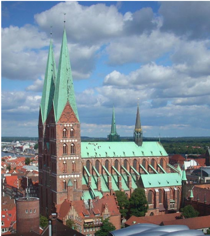
Fig.17 - Igreja Santa Maria, Lübeck, 1250-1350 – Igreja paroquial urbana. O material deu origem a uma fachada de estrutura discreta, com registos cuja homogeneidade não é interrompida mas sim realçada pelas telhas e pelos tijolos
