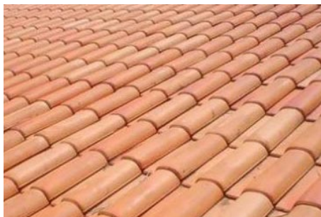
Fig.66 - Telha cerâmica: telhado
