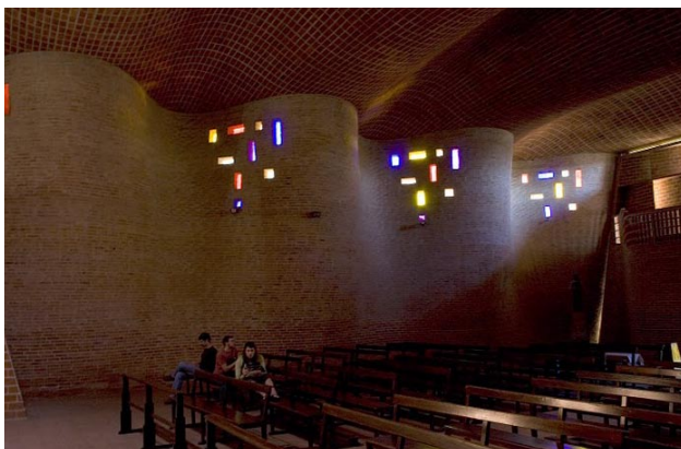
Fig.46 - Igreja de San Juan de Ávila, 1996-1999, E. Dieste, C. Clemente e J. de la Hoz - a secção concebe-se como parede 'capuchino' de duas folhas de meio pé cada uma, unidas por grampos cada metro na horizontal e vertical
