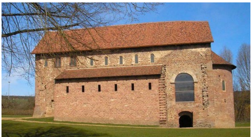
Fig.16 - Basílica Einhard em Steinbach, Alemanha 827 – caso de excepção, construído no período em que não havia acesso ao tijolo, por desconhecimento do seu fabrico no norte da Europa
