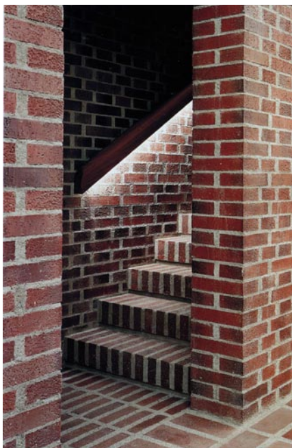
Fig.203 – Galeria de Arte Marktoberdorf, Alemanha, Valentin Beath y Andree Deplazes con Daniel Ladner - Nesta obra o material para além de caracterizar o exterior, também define os espaços interiores, levando ao limite o conceito de continuidade
