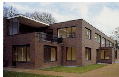
Fig.35 - Casa Lange e Esters (1927-1930), Crefeld, Alemanha, Ludwig Mies van der Rohe - utiliza o tijolo vermelho, lembrando a casa de campo de tijolo que Mies projectou em 1923.
