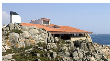
Fig.53 - Casa de chá, Leça da Palmeira, 1958-1963, Siza Vieira - as primeiras obras do Siza mostram um enorme esforço de reconstrução da tradição portuguesa em termos modernos. O ritmo em contraponto das coberturas de uma água do restaurante parecem ter-se inspirado parcialmente nas coberturas do Säynät-salo de Alvar Alato (1949-1952). Esta cobertura de duas águas de telha árabe e a chaminé têm também afinidades mediterrânicas.
