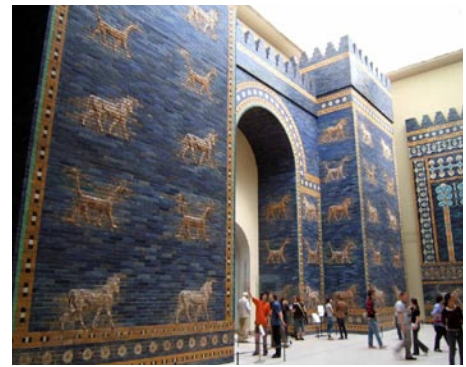
Fig.3 - Porta Isthar, séculos VII-VI a. C. – Porta com um arco erguido a 14 metros de altura, decorada com figuras montadas em relevo através da combinação de tijolos vulgares e de tijolos esmaltados
