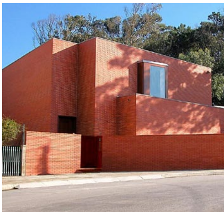
Fig.197 – Alvenaria de tijolo cerâmico
