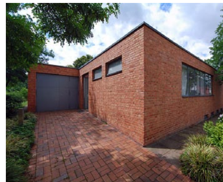
Fig.126 – Pavimento disposto numa disposição de trama de cesta - Casa Land Lemke, Mies Van der Rohe
