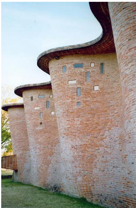
Fig.45 - Igreja da Atlântida, 1951-1957, Eladio Dieste – exemplo da utilização da cerâmica estrutural
