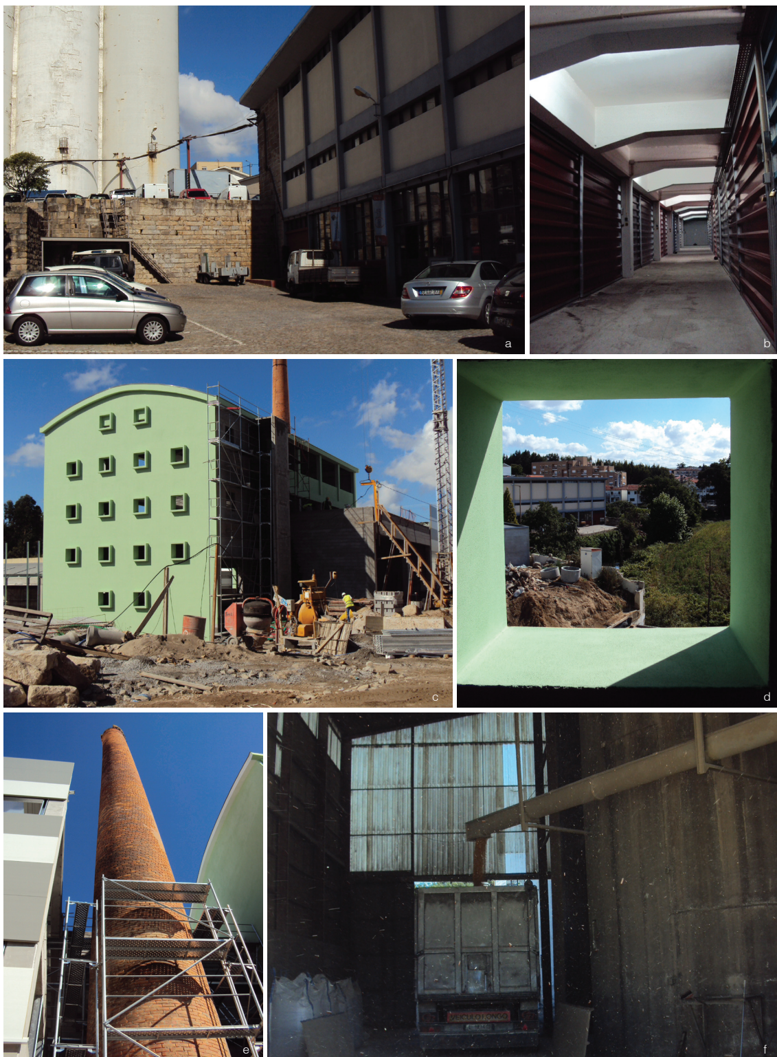
64. Soares & Irmão, Rua Ponte da Pedra, 1955, Arménio Losa e Cassiano Barbosa (estado actual) |a.Depósito |b.Depósito (interior) |c.Edifício para depuração de óleos |d.Vista a partir do edifício de depuração de óleos |e.Chaminé |f.Silos
