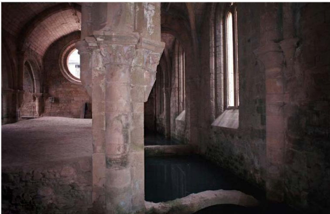
111: Situação do interior da igreja de Santa Clara-a-Velha em 1989. Arquivo IPPAR.
