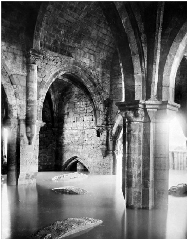
107: Interior da igreja com a constante presença da água na cota primitiva, cerca de 1976-78. Arquivo DGEMN.
