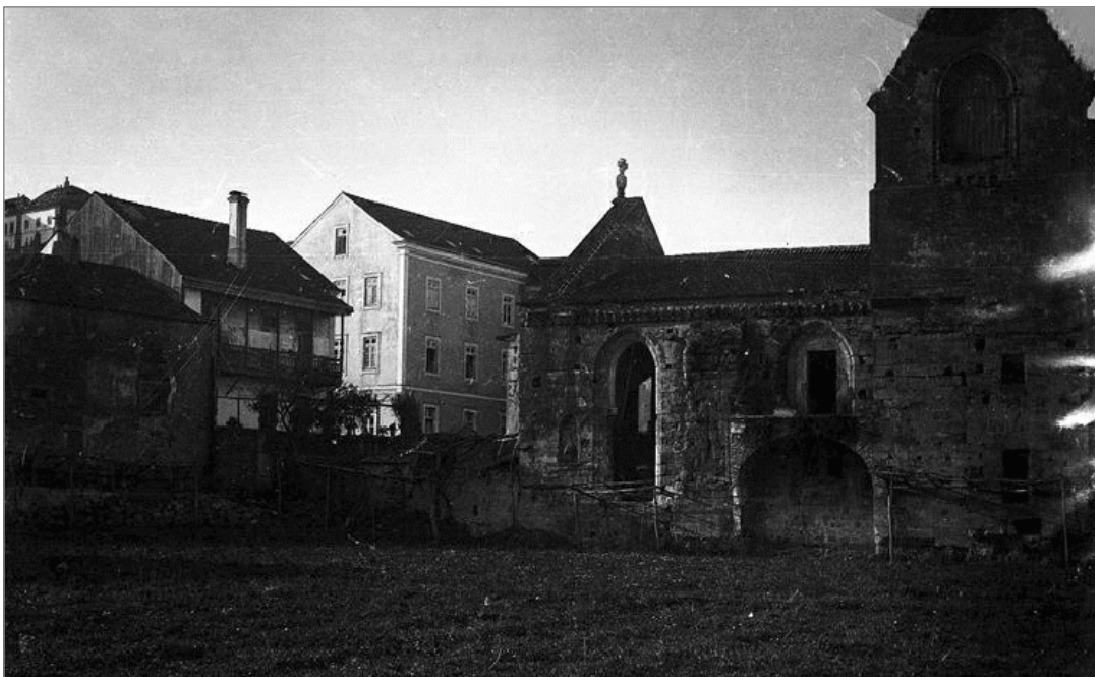
89: Demolição da parede da habitação na janela adaptada a entrada quando o piso primitivo ficou inundado, intervenção levada a cabo pela Comissão dos Monumentos Nacionais, cerca de 1928. Arquivo DGEMN.
