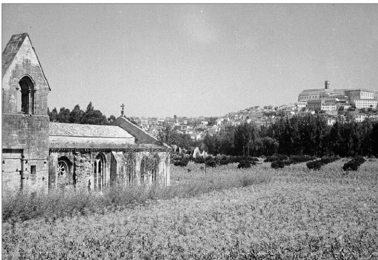
100: Antiga cerca monástica coberta por área agrícola, cerca de 1942. Arquivo DGEMN.
