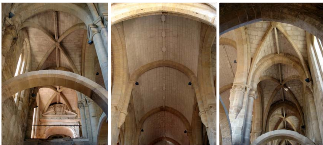
19, 20 e 21: Sistema de abóbadas nas nave sul, central e norte de Santa Clara-a-Velha. Fotografias de Rita Cruz, 2011.
