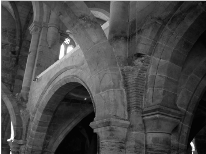
91: Arranque de abóbada de tijolo (demolida) que suportava o piso do séc. XVII. Fotografia de Rita Cruz, 2011.
