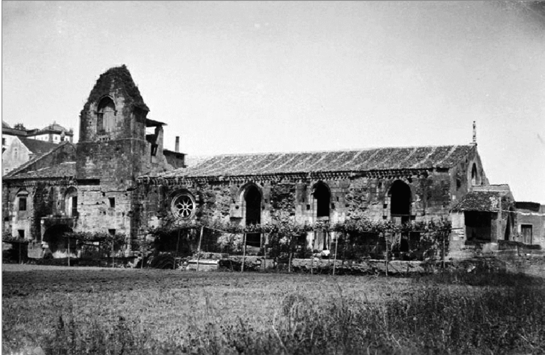
88: Demolição das paredes da habitação na zona referente aos leigos, intervenção levada a cabo pela Comissão dos Monumentos Nacionais, cerca de 1928. Arquivo DGEMN.
