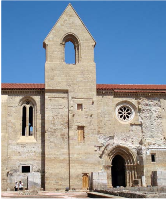
63: Campanário da igreja de Santa Clara-a-Velha. Fotografia de Rita Cruz, 2011.
