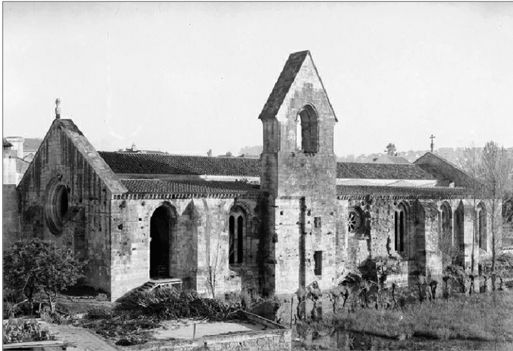
99: Campanário reconstruído e nova cobertura, 1958. Arquivo DGEMN.
