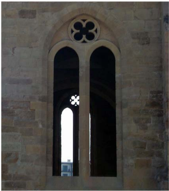
64: Janela alongada na fachada Norte da igreja. Fotografia de Rita Cruz, 2011.
