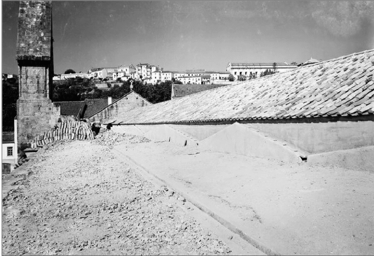
98: Assentamento de telha na cobertura da nave lateral sul, 1942. Arquivo DGEMN.
