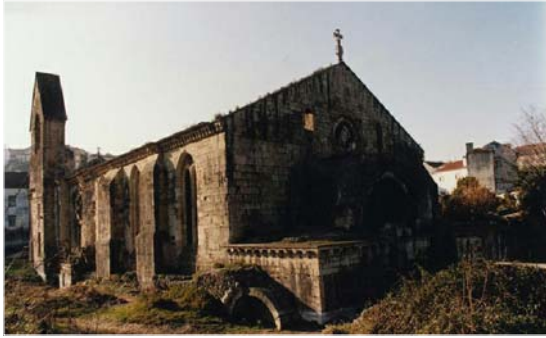
119: Início dos trabalhos do IPPAAR na cobertura, 1994. Arquivo IPPAR.
