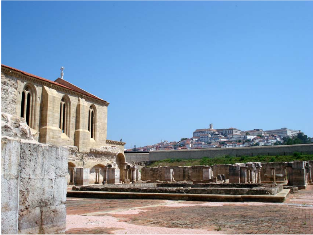
178: Claustro maior com a Alta de Coimbra como pano de fundo. Fotografia de Rita Cruz, 2011.
