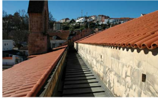
120: Nova cobertura com "caleirão" de cobre. Fotografia de Artur Corte Real.
