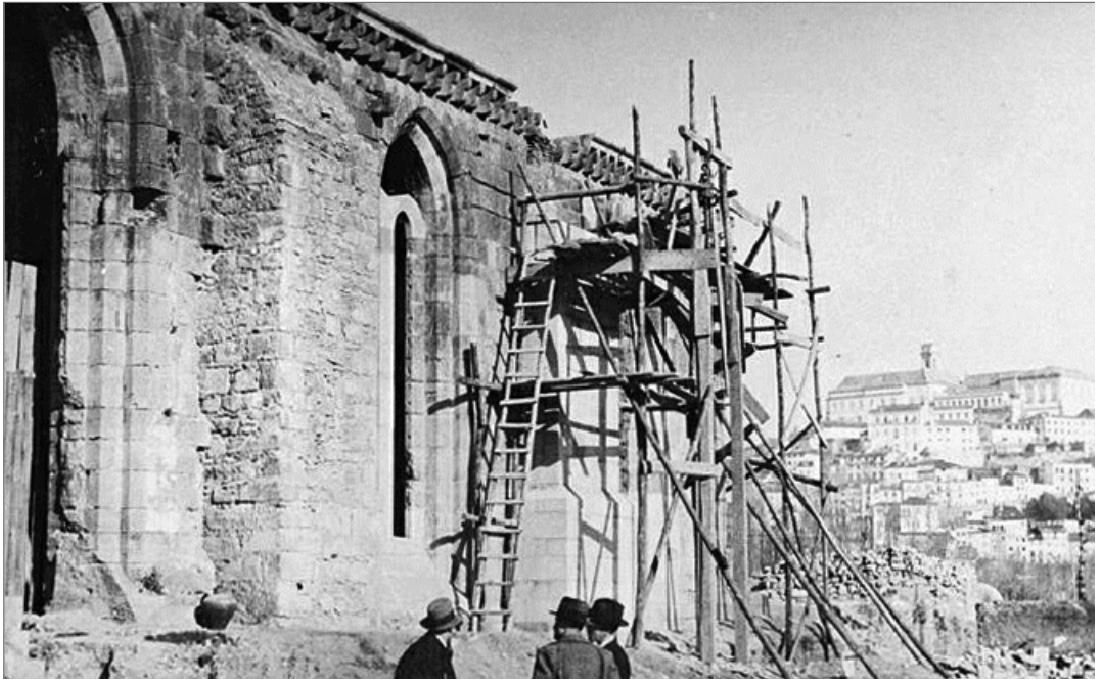
95: Reparações na cornija da fachada Sul, cerca de 1934-35. Arquivo DGEMN.
