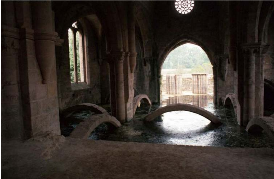
110: Situação do interior da igreja de Santa Clara-a-Velha em 1989. Arquivo IPPAR.
