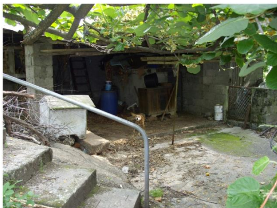
Fig.41- Esta é uma das casas construídas em finais da década de 60 e início de 70. O seu proprietário era emigrante, no entanto, tinha poucos recursos económicos. Embora na sua construção fossem já aplicadas técnicas e materiais da época, como paredes duplas e betão armado na estrutura, notam-se ainda algumas influências das casas anteriores, sobretudo na cozinha. Como usual nas casas que surgiram a partir desta época, existem nas traseiras os anexos feitos posteriormente para abrigar animais e utensílios ligados à agricultura.
