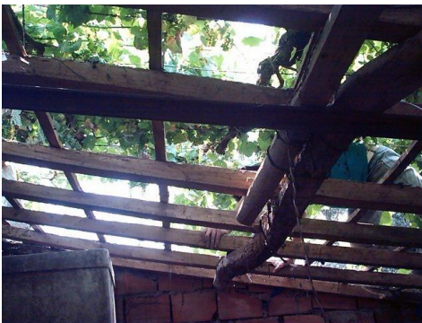
Fig.54- Estrutura da cobertura original.
