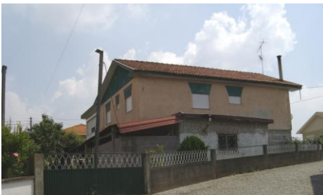
Fig.33, 34 e 35- Exemplos de casas construídas nas décadas de 60, 70 e 80.
