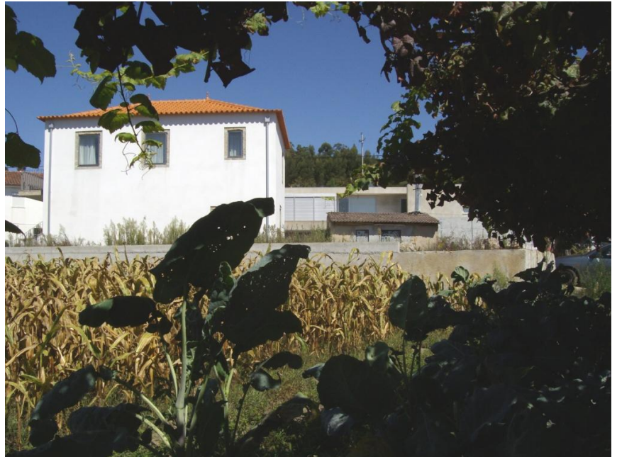
Fig.49- Vista do Barracão e da residência paroquial restaurada.
