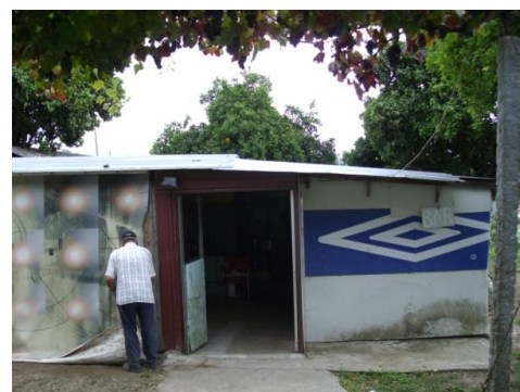
Fig.71,72 e 73- Estas imagens representam mais um exemplo de auto-construção. Com o aproveitamento de vários tipos de materiais (madeira, metal, betão e até toldos publicitários), um grupo de populares construiu um espaço para realização de actividades com vista a angariação de dinheiro para a restauração da residência paroquial.
