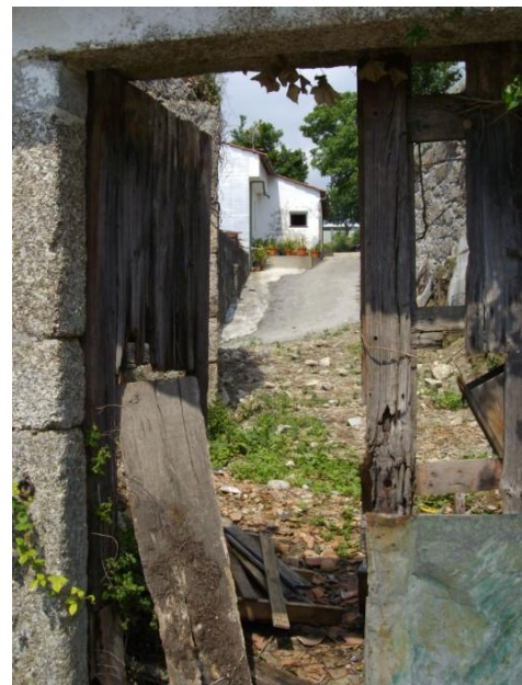
Fig.27- Estado de degradação de um dos antigos portais que faziam a transição entre a rua e as casas de lavoura.
