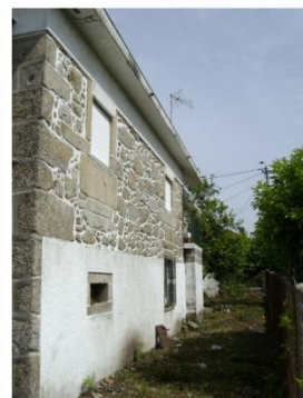
Fig.30- Nesta antiga casa de lavoura, podemos ver algumas das características construtivas referidas anteriormente. A organização espacial e funcional hoje é bastante diferente da original e apresenta algumas alterações, que servem de introdução ao que vamos ver de seguida.
