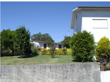
Fig.38, 39 e 40- Exemplos de alguns anexos construídos para satisfazer as necessidades de uma vida que ainda mantém alguns hábitos rurais.
