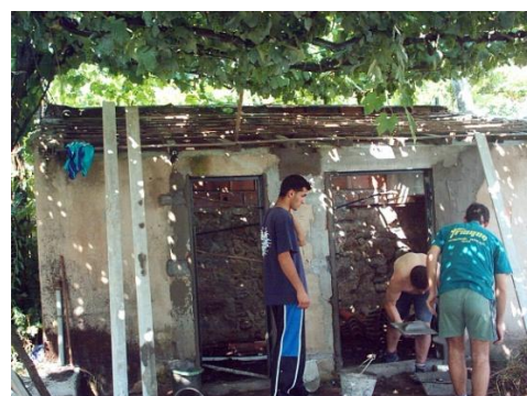
Fig.55 e 56- Obras de transformação deste anexo, numa cozinha improvisada, executadas pelos próprios escuteiros.
