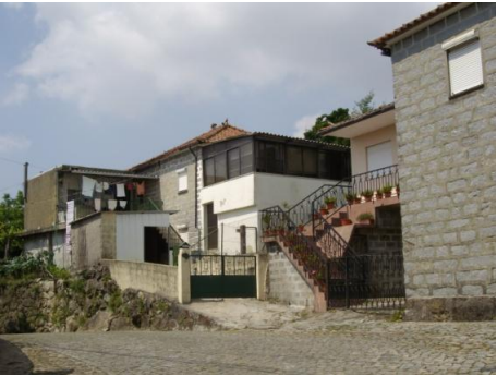
Fig.66 e 67- Alguns exemplos da auto-construção.
