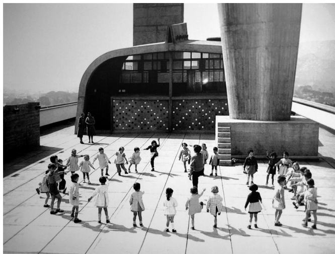
Fig.25.1, Fig.25.2, Fig.25.3 Unidade de Habitação, Marselha, França, Le Corbusier, 1947-52
