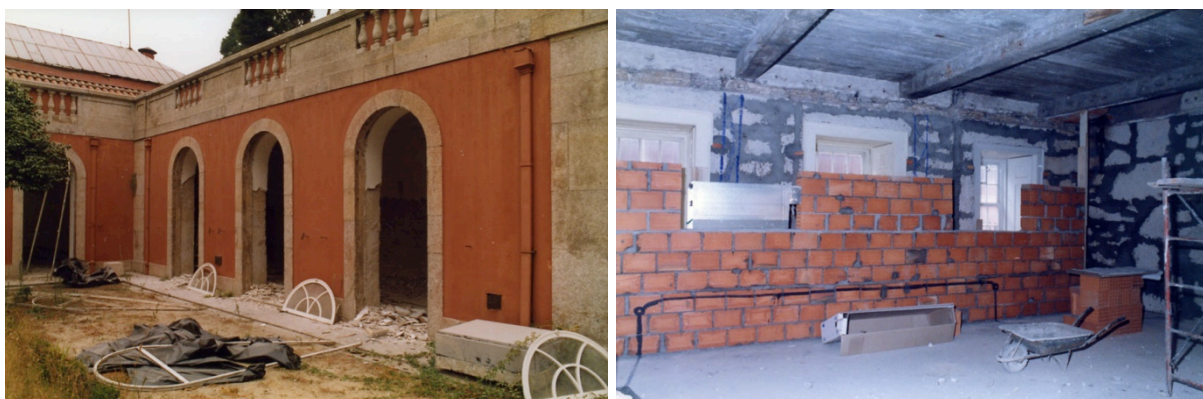
Obras dos anos 90. Tamponamento de algumas entradas laterais de luz natural.
