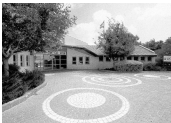
Img. 46.- Pátio central
