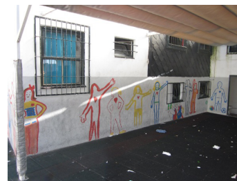
Img. 76.- vista do alçado virado para o pátio
