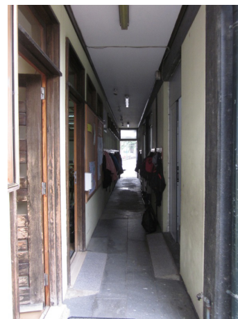
Img. 61.- corredor de acesso aos pavilhões e ao refeitório
