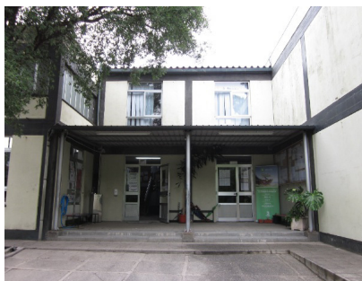
Img. 60.- vista exterior da entrada
