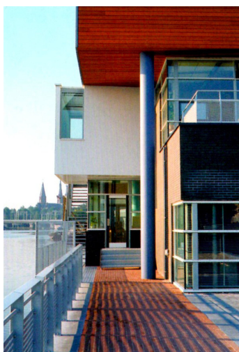
Img. 51.- vista da cobertura
