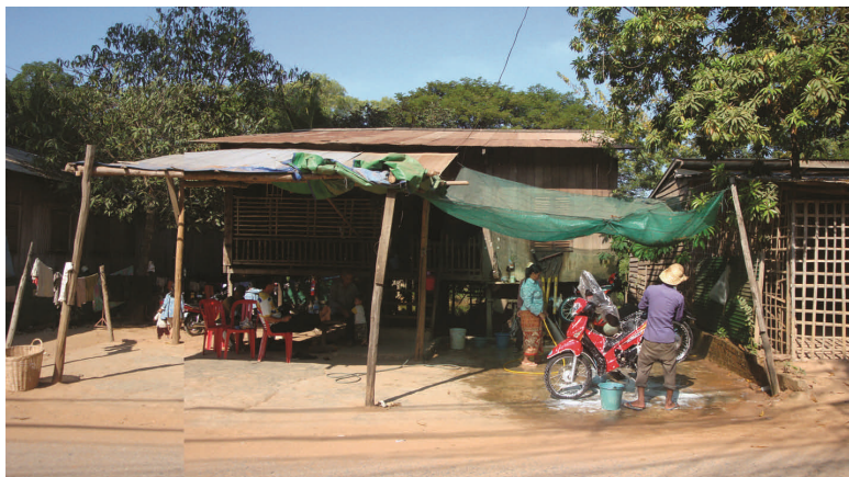
Fig.19. Espaço exterior entre a casa e a rua.
