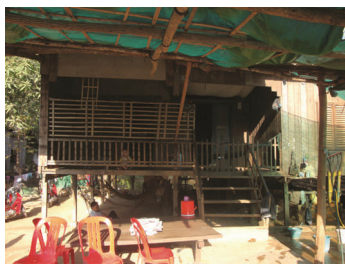
Fig.21. Fachada para a rua: a loggia.
