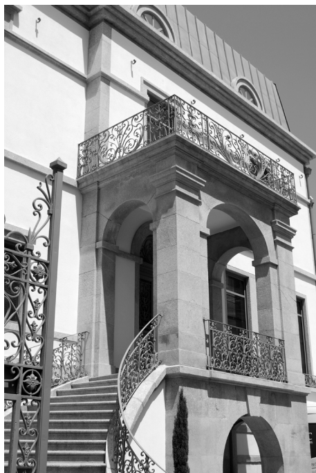
31, 32 Casas Soares Moreira Pormenor da entrada Fotografia Actual 2011
