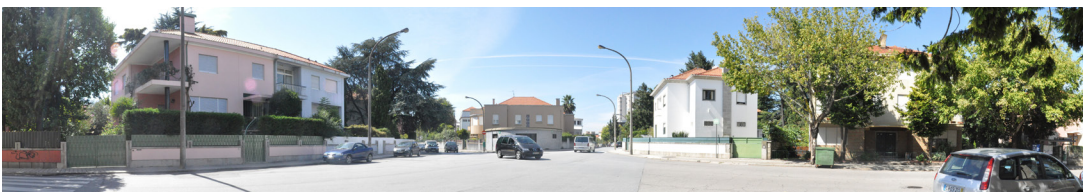
49, 50, 51, 52, 53. levantamento fotográfico do local. Cruzamento Rua do Amial com a Rua do Doutor Carlos Ramos; Rua do Conde D'Avranches; Rua do Doutor Carlos Ramos; Rua Coronel Almeida Valente; panorâmica geral.
