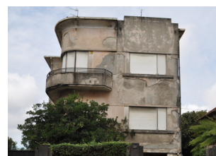
32, 33, 34. fotografias de exemplos de arquitectura moderna na cidade do Porto. (Avenida Marechal Gomes da Costa e Rua do Amial)
