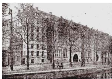
Fig.18. Habitação construída pela Sociedade “Amsterdamsch Bounfonds”, Holanda.
