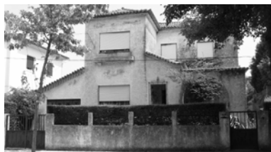
Fig.32. Rua Garcia da Orta, 22-32. João Queiroz, arq. 1943. Habitação própria.
