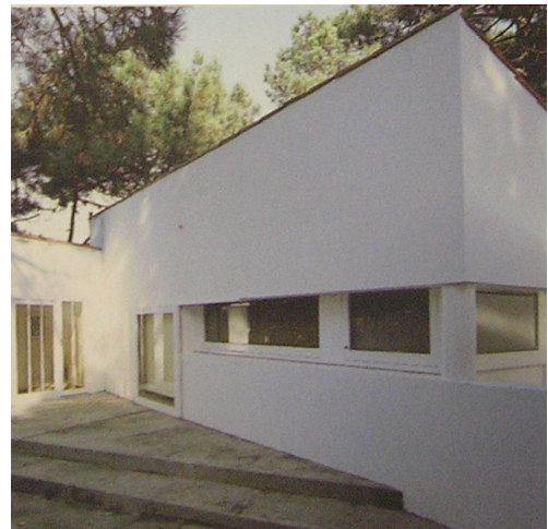
Fig. 84 Casa Alves Costa, entrada.
