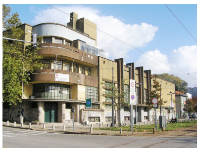
Fig. 18 Armazéns Frigoríficos de Massarelos, Porto, Januário Godinho, 1934 Visita 10/11/2010
