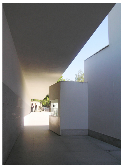
Fig. 47 Vista Norte do Museu de Arte Contemporânea da Fundação Serralves, Porto, Álvaro Siza, 1991-1999 Visita 26/04/2011
