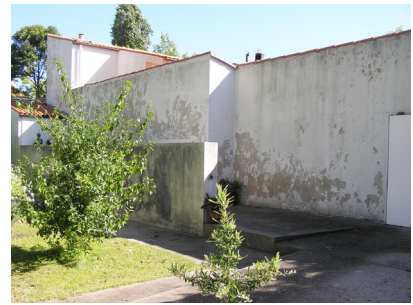
Fig. 78 Casa Alves Santos, Vila do Conde.
