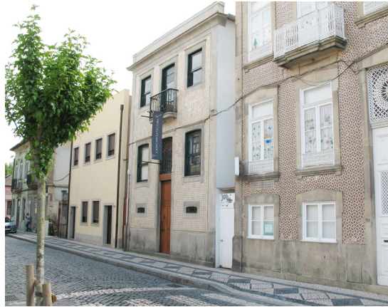
Fig. 94 Remodelação da Casa dos Pais, vista da Rua Roberto Ivens, Matosinhos.
