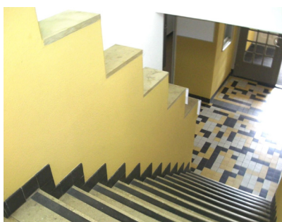
Fig. 12 Detalhe da escada da Casa de Vonk, Pieter Oud, 1917-1919
