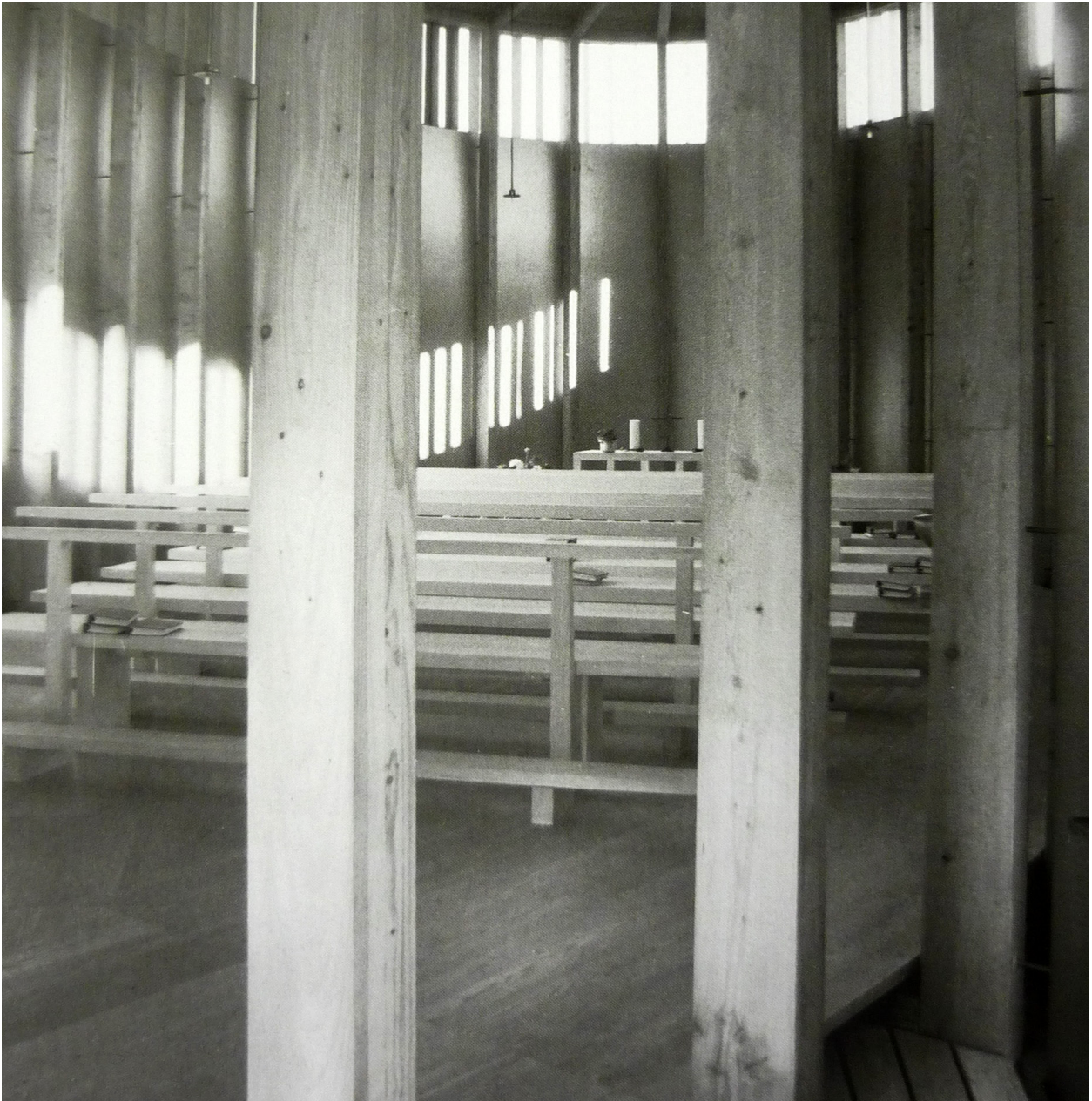
Fotografia do interior da igreja. São, aqui, claramente perceptíveis os pilares de madeira destacados da parede, bem como o pavimento, que como que flutua acima do nível do terreno.
