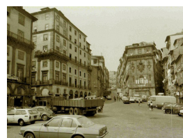
14. Praça da Ribeira antes e depois da intervenção do CRUARB
