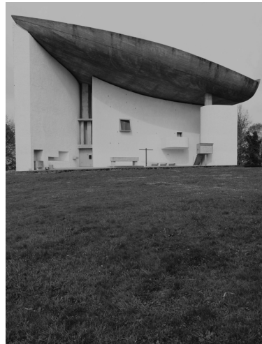
112 Exterior da capela, vista nascente
