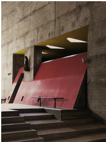
92 Parede curva da sacristia
