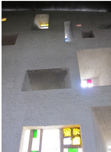
120 Pormenor da parede sul
