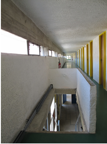
86 Corredor de acesso às celas
