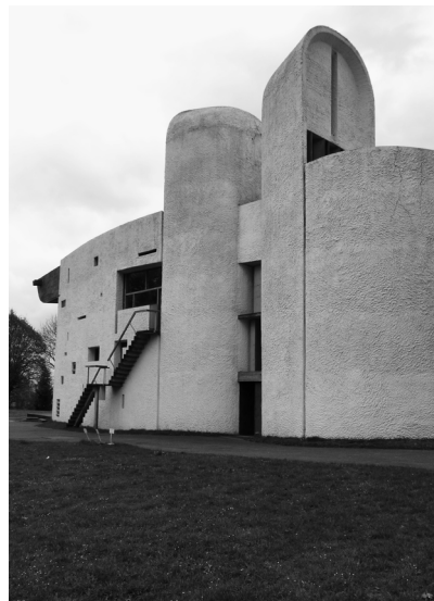
118 Entrada, torreões e escada para sacristia
