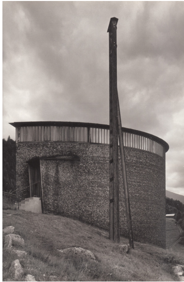
57 Exterior da capela
