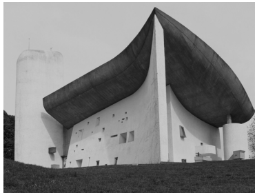
108 Exterior da capela, vista sudeste
