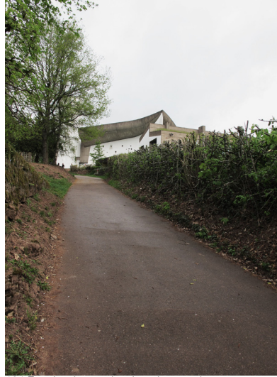
104 Exterior da capela, vista da entrada
