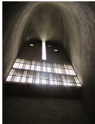
128 Torreão da capela alta, norte
