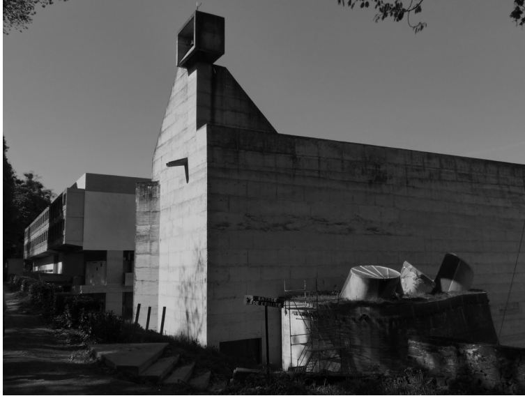
74 Exterior do convento, visto do percurso de chegada
