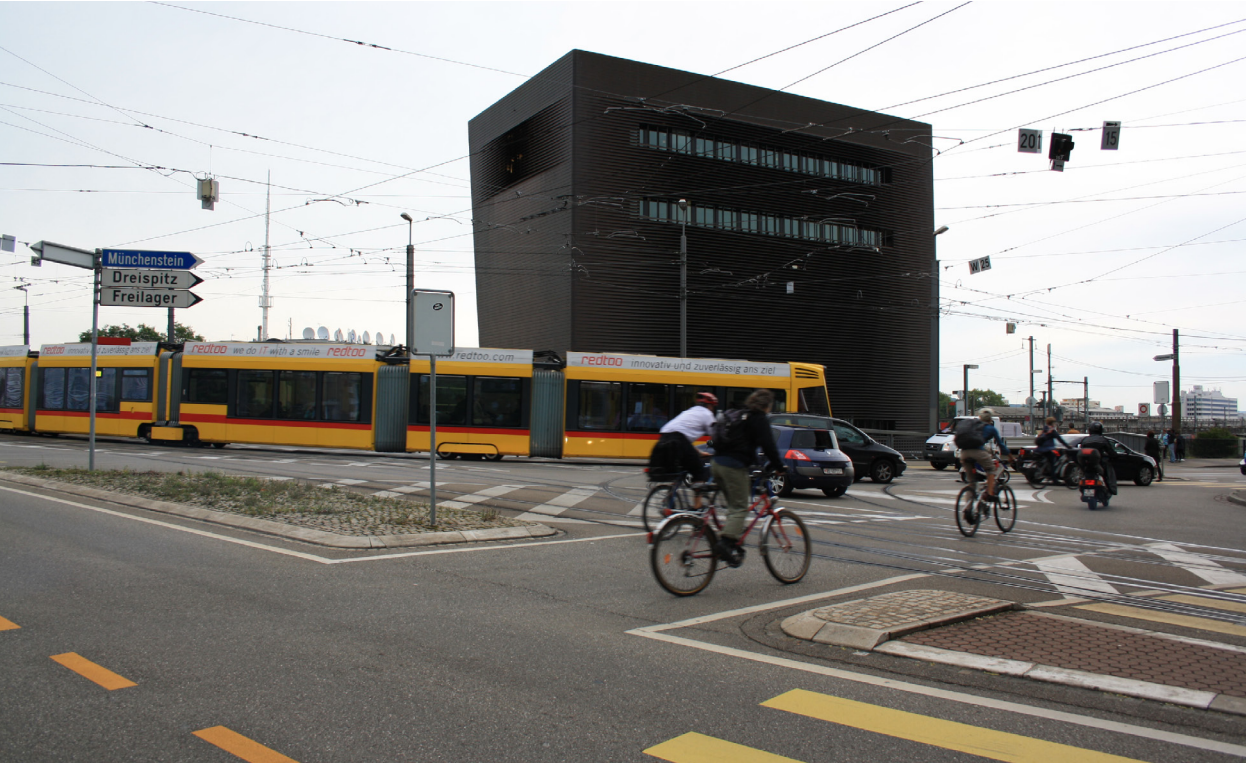
#59 ’signal box 2’, herzog & de meuron; 1997
