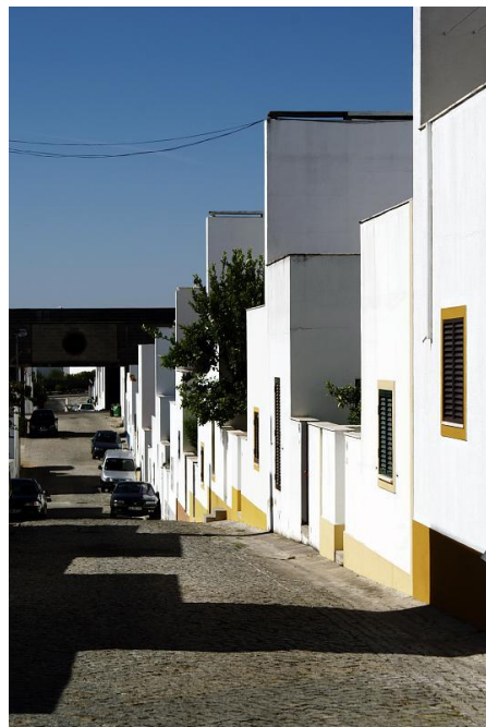
41. vista de habitações e sistema de infra-estruturas
