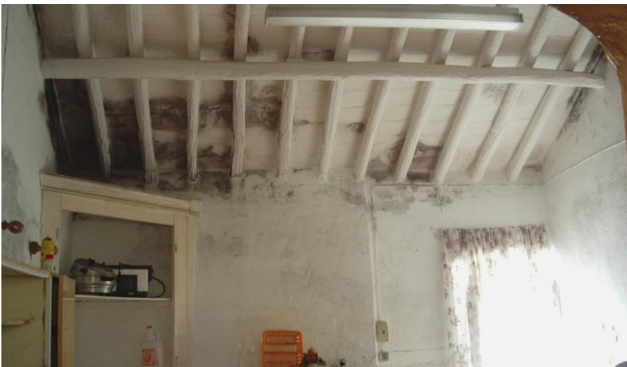
16.interior de habitação piso superior
