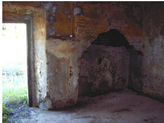
31.pormenor da abobadilha no interior da habitação
