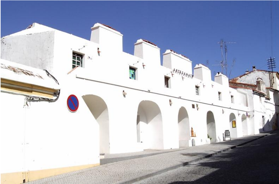
23.vista da fachada principal
