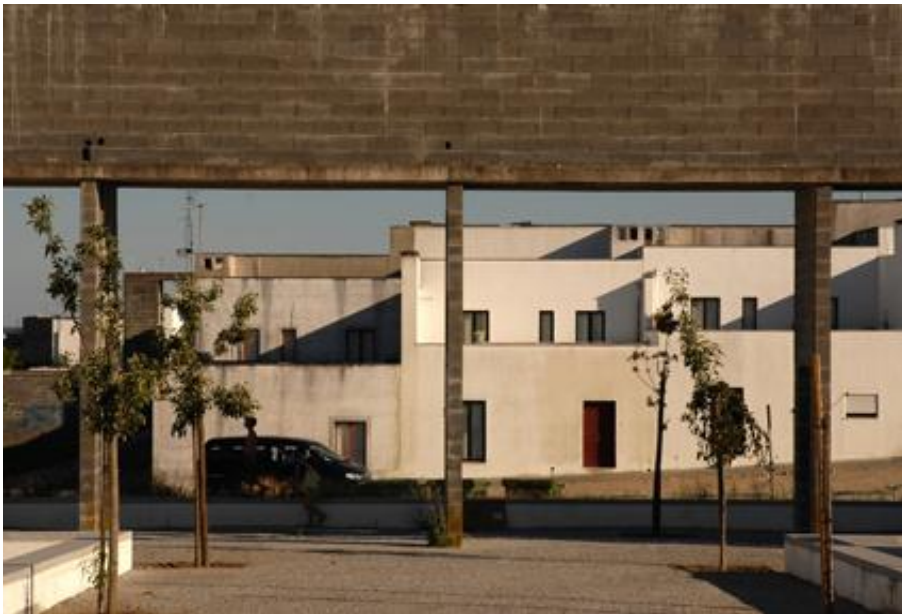
45. vista de habitações e sistema de infra-estruturas
