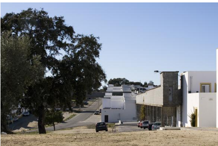
37. vista de linha de habitações e sistema de infra-estruturas
