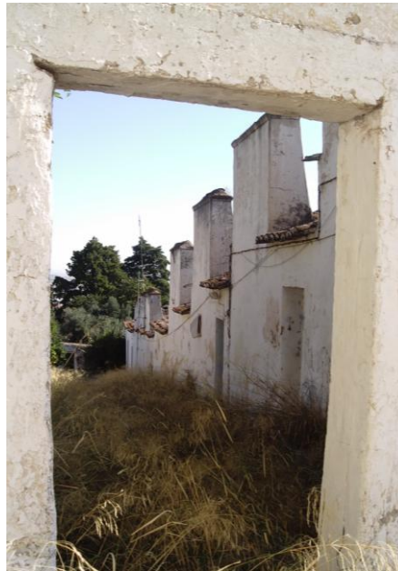
14.vista da fachada principal
