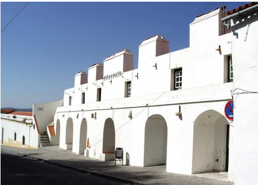
26.vista da fachada principal
