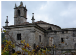
Compartimentos a ponte
