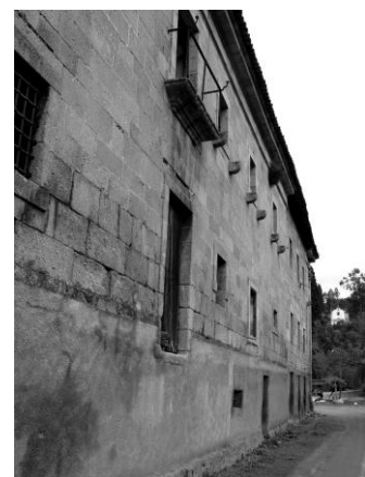
21 – Fachada sul dos compartimentos adjacentes do claustro.
