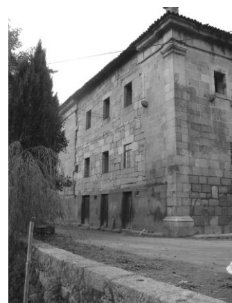
22 – Fachada sul dos compartimentos adjacentes do claustro.
