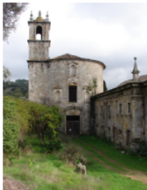
Fachada principal da igreja
