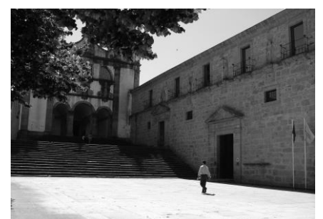
30 – Mosteiro Santa Maria do Bouro. Planta de implantação. Alçados. Vistas da junção da parte antiga com o volume novo.
