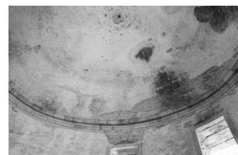
24 – Abóbada da igreja.
