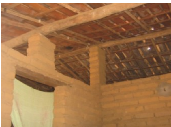
Figura 116 - Cobertura com telhado cerâmico e madeira de desgalhe, habitação tradicional em Viçosa do Ceará. Fonte: (CARVALHO, 2012).
