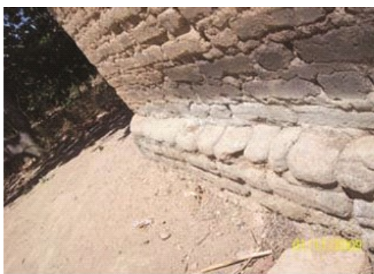
Figura 114 - Fundação Baldrame em pedra com argamassa cimentícia. Fonte: (CARVALHO, 2012)
