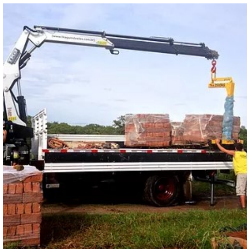
Figura 78- adoberia – transporte de adobes.
