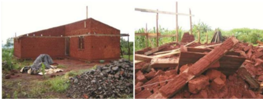
Figura 51: Assentamento rural Sepé Tiaraju, Casa de adobe antes e depois do colapso. Fonte: MAIA 2011).
