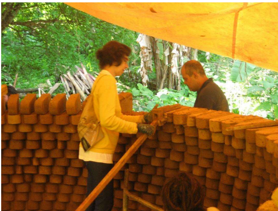
Figura 73 – adobes com formatos especiais. Fonte: (MINKE, 2005)
