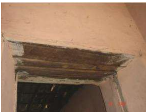
Figura 118 - Verga em madeira de uma habitação de adobe tradicional. Fonte: (CARVALHO, 2012).
