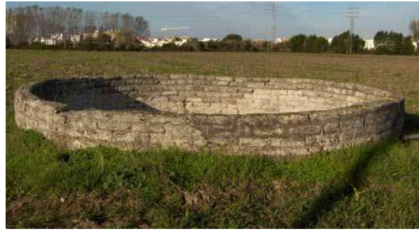
Figura 59 - Adobe em paredes de poços de água. Fonte: (VARUM et al. 2005).
