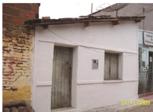
Figura 123- Argamassa de cal, casa tradicional em adobe. Fonte: (CARVALHO, 2012).
