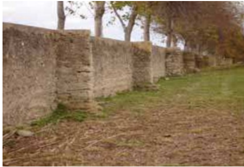
Figura 58 - Muro com contrafortes. Fonte: (VARUM et al. 2005)
