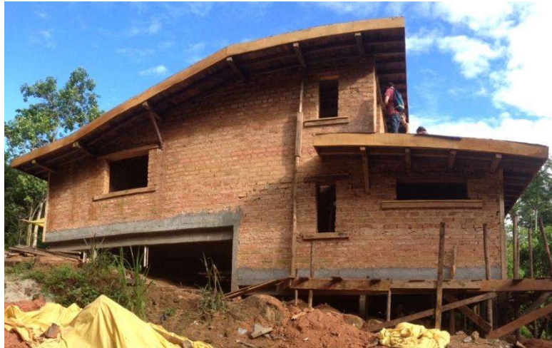
Figura 61 - Edificação em adobe com 02 pavimentos - Casa de campo, Brasil, 2016 (CAVALCANTE 2016).
