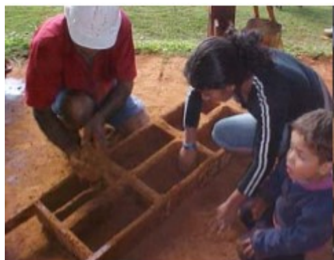
Figura 44 – Capacitação da comunidade na produção de adobes no assentamento Fazenda Pirituba, Itapeva – SP, 2005. Fonte: (SILVA 2007).
