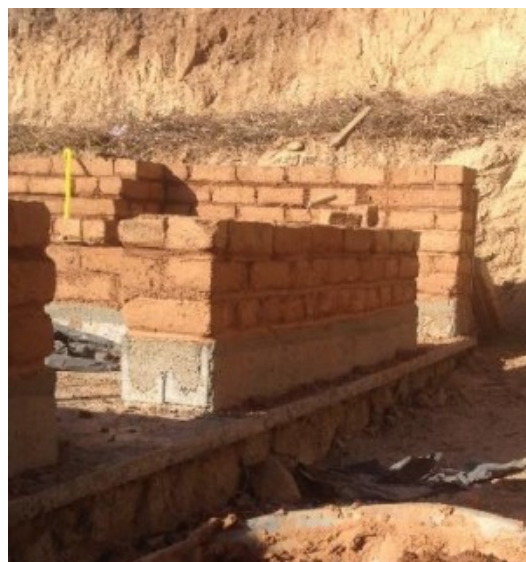
Figura 83 – Proteção para base das paredes. Fonte: (HOLANDA, 2016).
