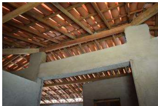
Figura 117 - Cobertura com telhado cerâmico e madeira de serrada, habitação tradicional em Ibiapina. Fonte: (ALCÂNTARA et al., 2018).
