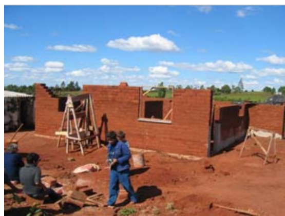
Figura 4 – Construções de unidades habitacionais em adobe no assentamento Fazenda Pirituba, Itapeva – SP, 2005. Fonte: (SILVA 2007).
