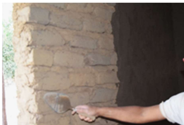
Figura 122- Argamassa de solo cimento, casa tradicional em Ibiapina. Fonte: (ALCÂNTARA et al, 2018).
