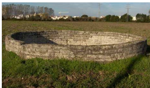
Figura 75 - Adobe em paredes de poços de água. Fonte (VARUM et al., 2005).
