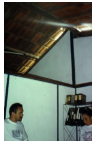
Figura 40 – Residência Serra Azul, vista interna (LOPES 1998).
