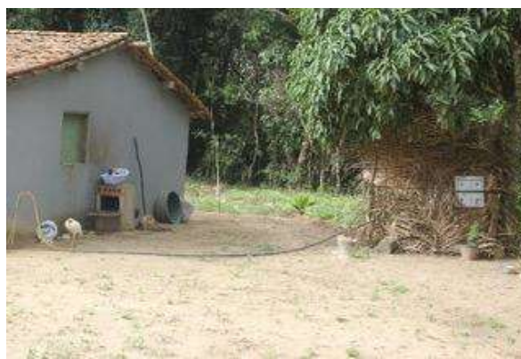
Figura 112 – habitação precária no município de Ubajara, tipo casa com banheiro improvisado com parede de palha.
