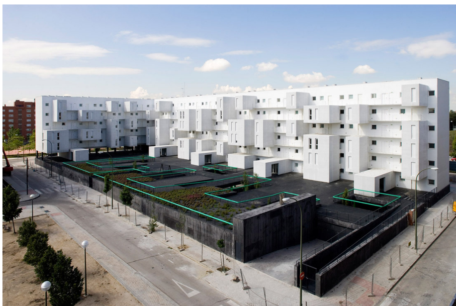
Viviendas en Carabanchel Gabinete Dosmasuno, 2003-07 fig.63 Vista das fachadas posteriores e do logradouro
