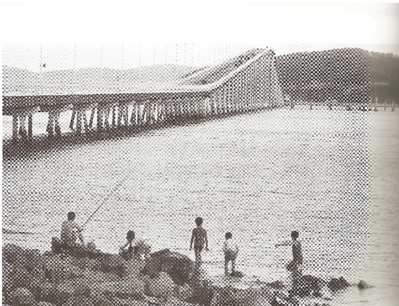
Fig. 25 - Ponte Nobre de Carvalho.
