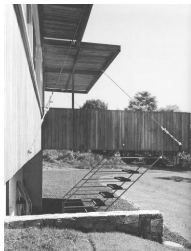
[17] Vista da varanda que se projecta para o exterior, Casa Breur II.
