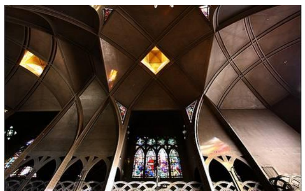
-116- Vista interior da cobertura da Igreja de Saint Jean de Montmartre. Embora formalmente predominem as referências góticas, as abóbadas e pilares em betão armado permitem uma estrutura de grande esbelteza contribuído para uma nova noção espacial.
