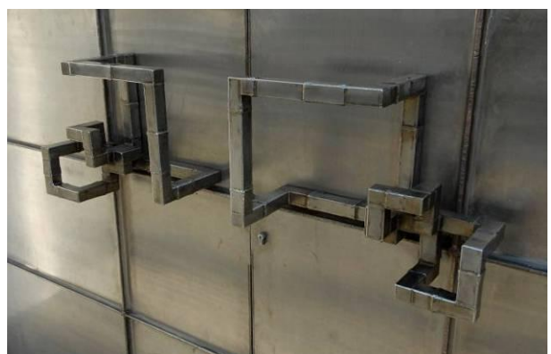
-191- Pormenor do puxador da porta de entrada da Igreja de Achean.
