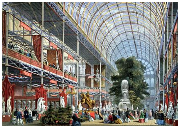
-96- Vista interior do Crystal Palace concebido por Joseph Paxton.
