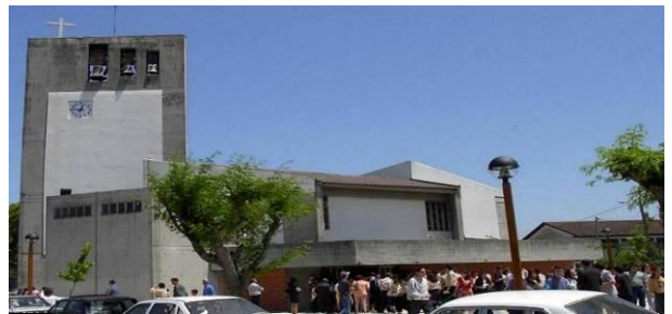
-389- Vista exterior da Igreja Paroquial de Calvão (1969-70),
