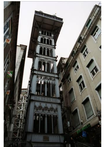
-132- Elevador de S.ª Justa, Lisboa por Mesnier du Ponsard, 1900-07.
