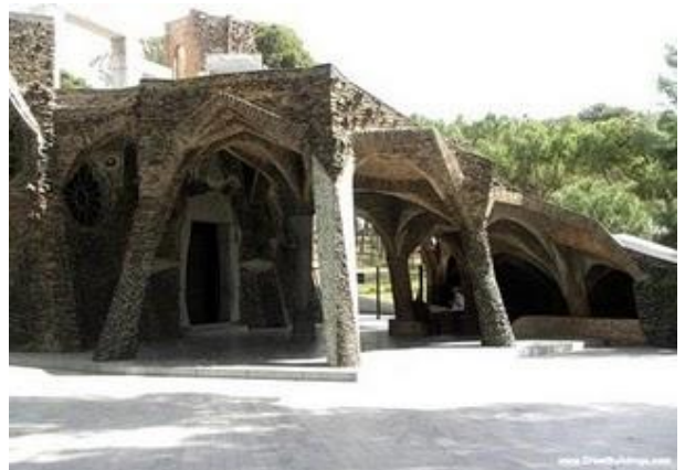
111 Vista exterior da inacabada Igreja da Colónia Güell.
