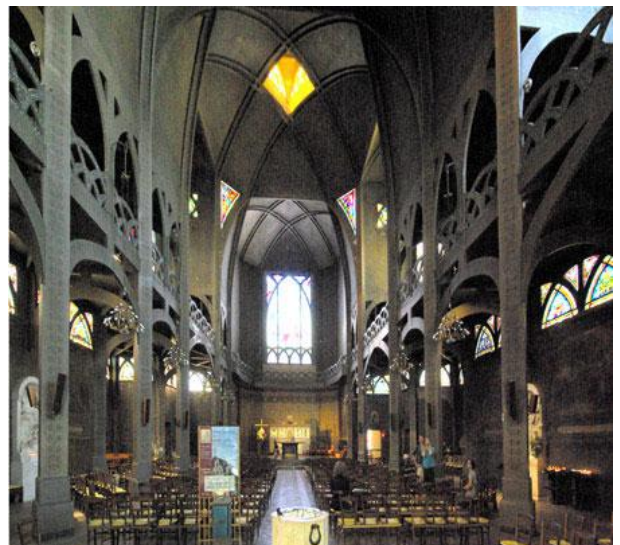
-115- Vista interior da Igreja de Saint Jean de Montmartre. A estrutura interna substituiu a pedra pelas potencialidades estruturais do betão armado.
