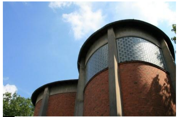
-233- Vista exterior da Igreja de S. Miguel (1953-54) projectada por Rudolf Schwartz .
