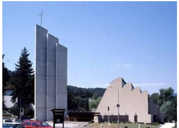
-343- Igreja e centro comunitário em Riola (1966) da autoria de Alvar Alto.
