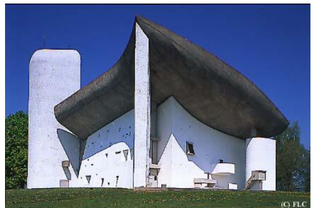
-249- Vista exterior da Capela de Notre-Dame-du-Haut em Ronchamp (1950-55) projectada por Le Corbusier .
