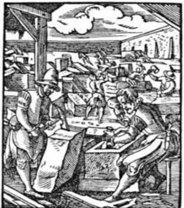
-86- Gravura representativa de um estaleiro de construção de uma catedral sendo visíveis os ofícios de pedreiro e de canteiro.
