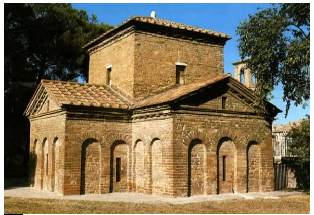
59- Mausoléu de Gala Placidia, em Revena um edifício de pequenas dimensões de planta cruciforme, trata-se de uma das construções mais notáveis do séc. V .
