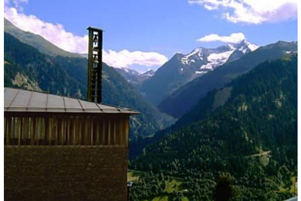
-355- Vista exterior da Capela de S. Bento.
