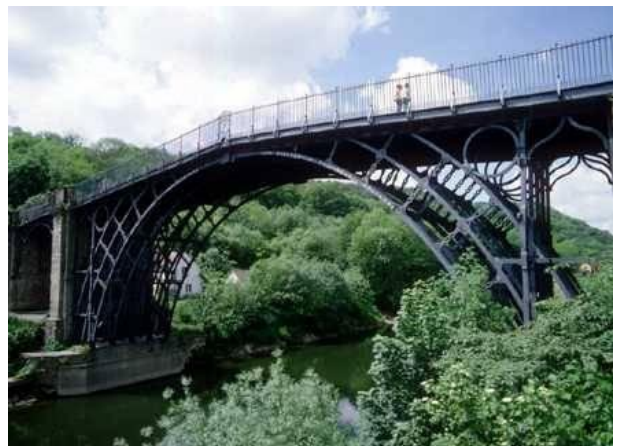
-92- Esta ponte, construída sobre o rio Severn, entre 1777 e 1779, foi a primeira ponte de ferro da história e representa o início da construção industrial moderna.
