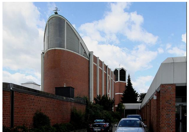
-229- Vista exterior da Igreja Santa Cruz (1952-57) projectada por Rudolf Schwartz.
