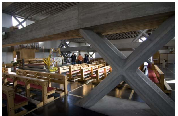
-321- Vista interior do Centro Paroquial de Ennsleiten, em Steyr na Austria.
