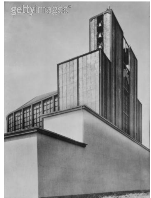
169. Vista exterior da Igreja em aço de Colónia (1928) projectada por Otto Bartning.
