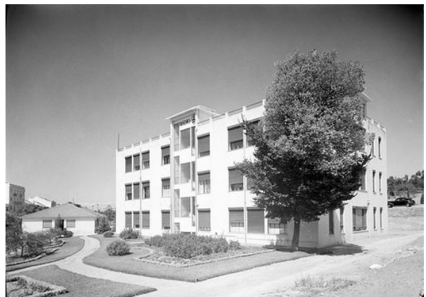
-197- Instituto Português de Oncologia Pavilhão da Rádio,(1927-33) projecto de Carlos Ramos.
