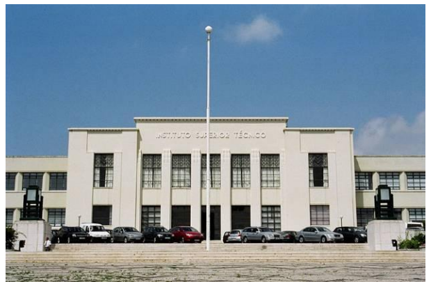
-196- Instituto Superior Técnico(1927-35) projectado por Pardal Monteiro.
