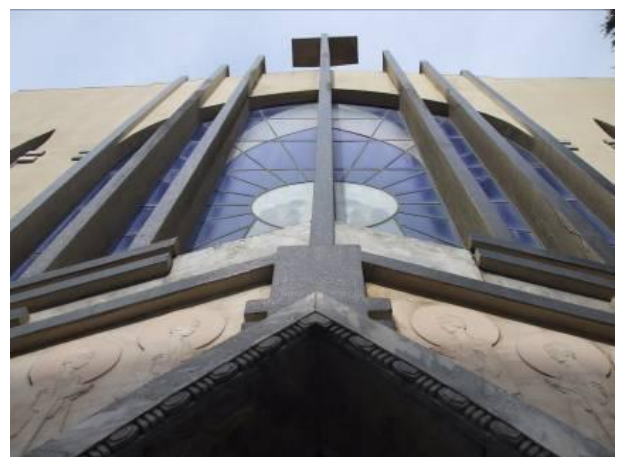
-202- Pormenor da fachada principal da Igreja de Nossa S a . De Fátima.
