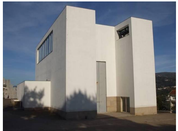
434 Igreja de St a . Maria no Marco de Canaveses (1990-95) projectada por Álvaro Siza.
