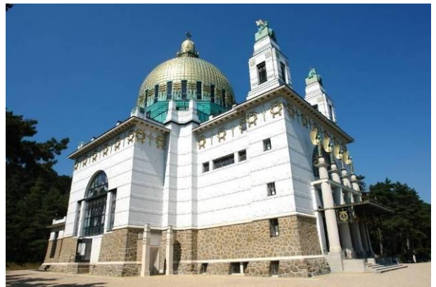
-119- Vista i exterior da Igreja S. Leopoldo em Steinhof, Viena (1902-07) projectada por Otto Wagner.
