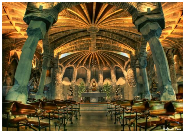
-109- Vista interior da igreja mostrando as inúmeras nervuras das abóbadas bem como os pilares monolíticos em granito.
