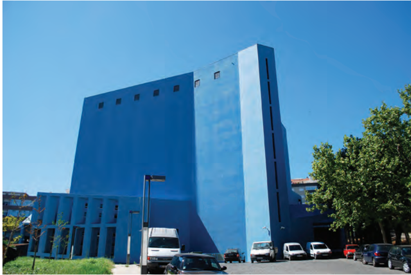
Figura 165 Vista Exterior (Este) Teatro Azul, Almada
