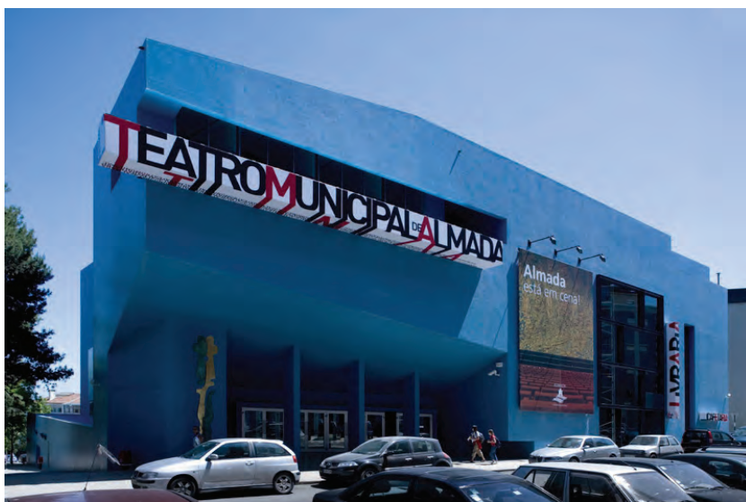
Figura 167 Vista Exterior (Oeste) Teatro Azul, Almada
