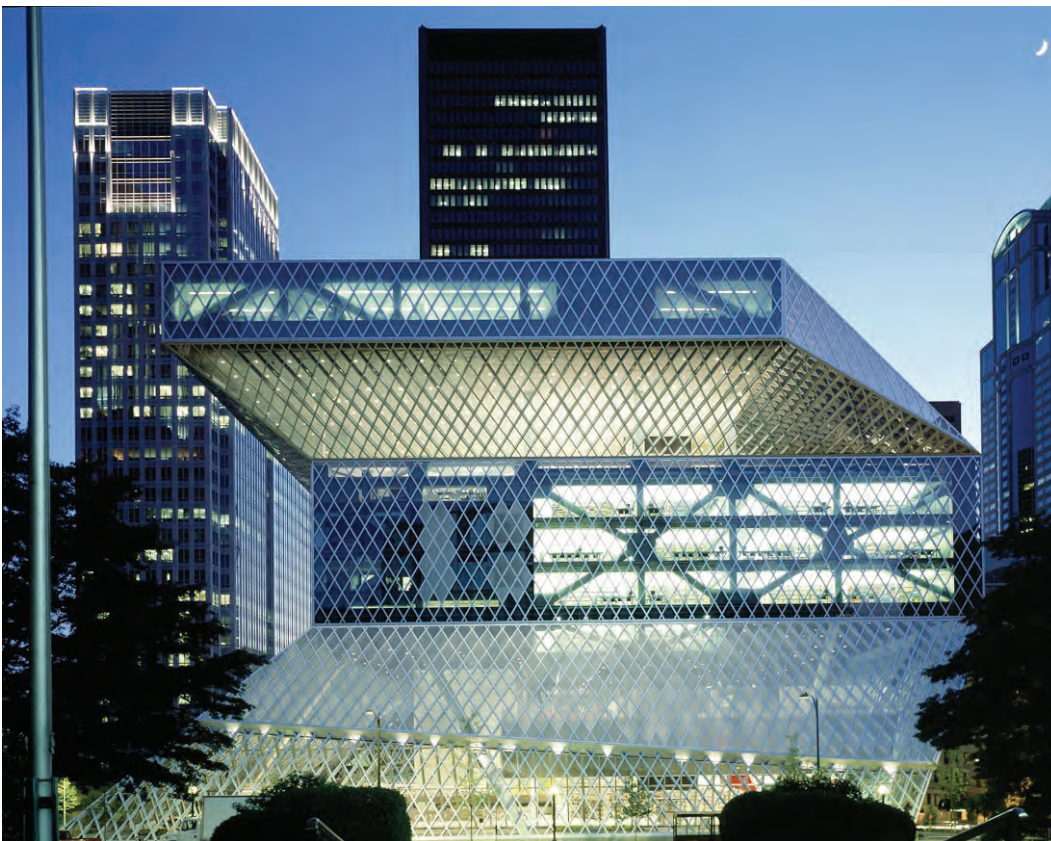
Figura 142 Vista Exterior Biblioteca Seattle, EUA
