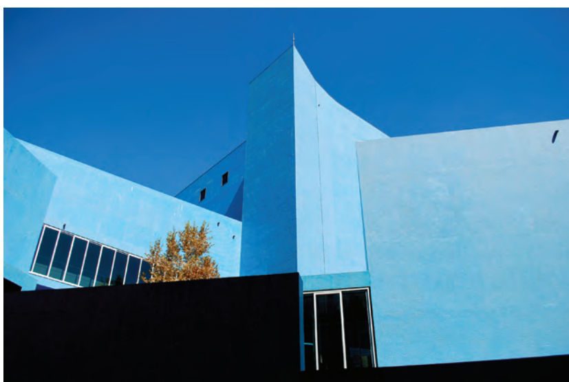
Figura 170 Vista Exterior: Volumetria dos dois Auditórios Teatro Azul, Almada
