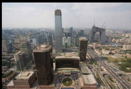
1. 48 – Vista aérea do Centro de Negócios - Pequim, China
