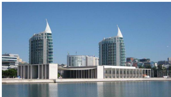
3.149 – Expo98, Lisboa – Pavilhão de Portugal Fonte: Google
