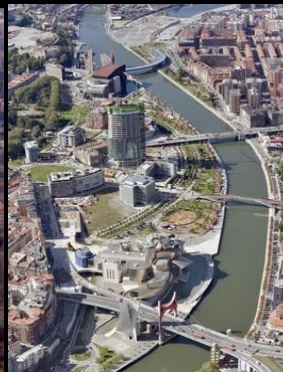
1.44 - Zona de intervenção (2009)
