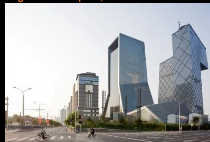
1. 50 – Vista de rua do Edifício CCTV
