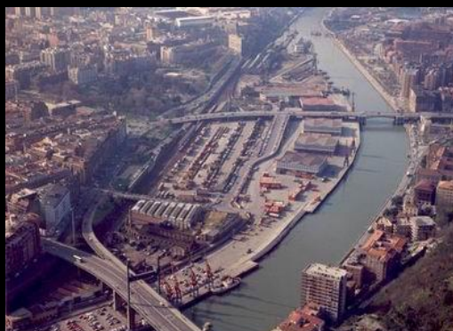
1.43 – Zona de intervenção (1992)
