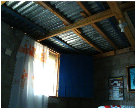
Fig.29 - Pormenor de cobertura de chapa ondulada metálica.
