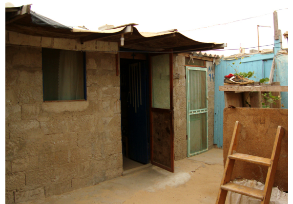
Fig.30 - Habitação na zona norte do Bairro de Chã de Salinas.
