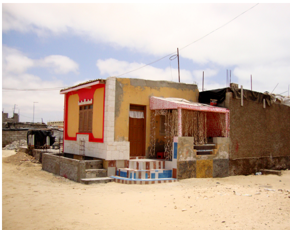
Fig.26 - Habitação unifamiliar no Bairro de Chã de Salinas
