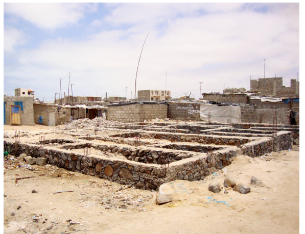
Fig.27 - Base de Fundação em pedra basáltica
