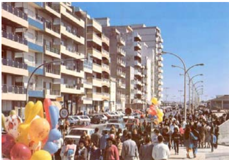
Foto 30 - avenida dos banhos
