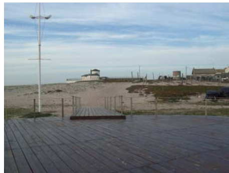
Foto 50 - Passadiço sobre o rio Esteiro
