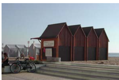
Foto 54 - barracas dos banheiros
