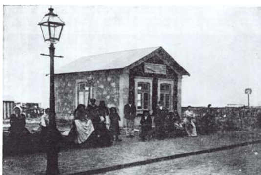
Foto 6 - casa das máquinas do Balneário Oceânia, sobre o areal
