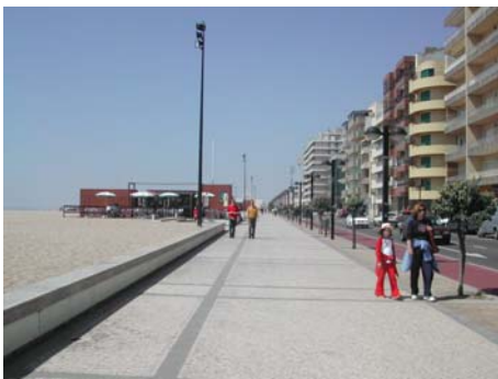
Foto 44 - Avenida dos Banhos
