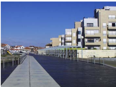
Foto 49 - Passadiço sobre o rio Esteiro
