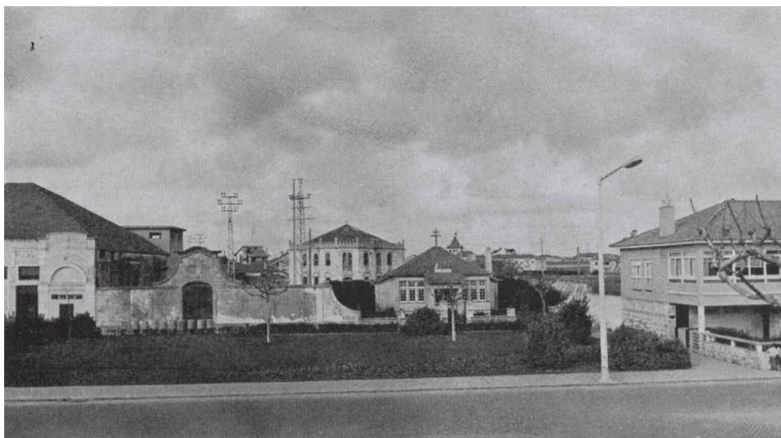
Foto 70 - Largo das Dores – em frente ao terreno do antigo cemitério o jardim
