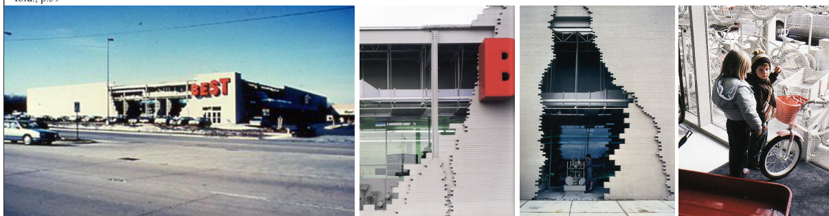
1. Vista exterior (quazen.com); 2. Pormenor da fachada 1 (WOMERSLEY, 2005: 58); 3. Pormenor da entrada (flickr.com); 4. Relação interior/exterior (WOMERSLEY, 2005:59)
