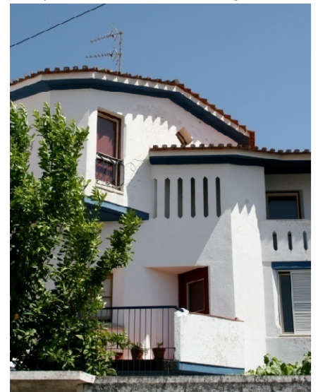
77 Casa Dr. Barata dos Santos _ vista Arq. N. T. Pereira e N. Portas, V. Viçosa, 1958
