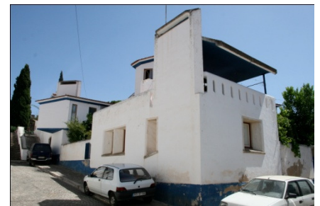
75 Casa Dr. Barata dos Santos _ vista Arq. N. T. Pereira e N. Portas, V. Viçosa, 1958
