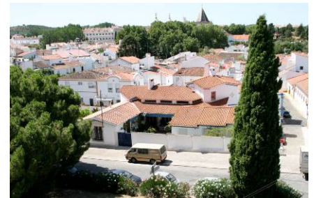
63 Casa Dr. Barata dos Santos _ vista Arq. N. T. Pereira e N. Portas, V. Viçosa, 1958
