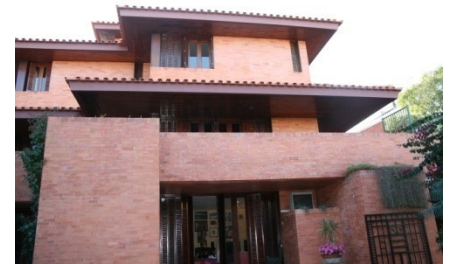
20 Casa Álvaro Trigo _ vista Arq. Maurício de Vasconcellos, Restelo, 1964
