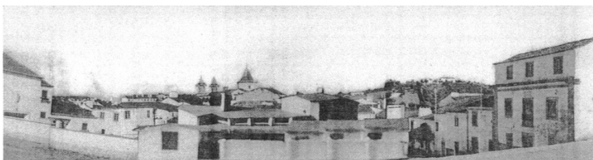
64 Casa Dr. Barata dos Santos _ vista Arq. N. T. Pereira e N. Portas, V. Viçosa, 1958
