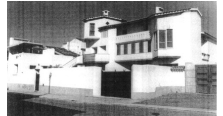
76 Casa Dr. Barata dos Santos _ vista Arq. N. T. Pereira e N. Portas, V. Viçosa, 1958
