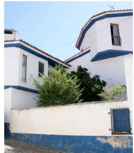
66 Casa Dr. B. dos Santos _ vista Arq. N. T. Pereira e N. Portas, V. Viçosa, 1958
