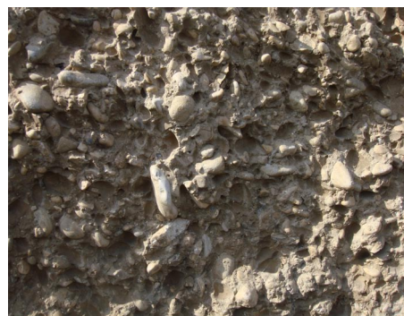
202 | Schaulager Laurenz Fondation Pormenor revestimento
