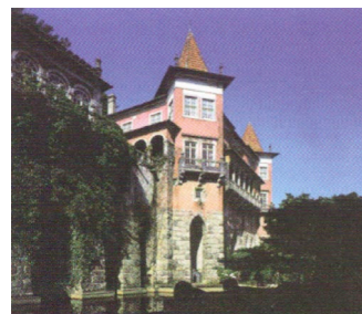
275 | Casa dos Penedos Vista exterior
