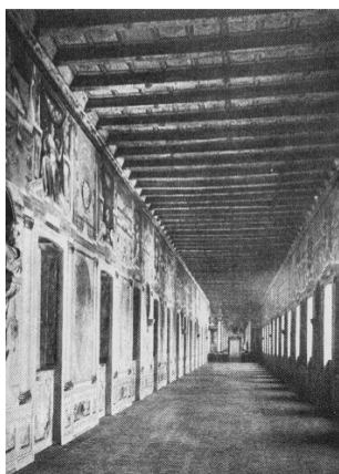
8 | Galleria de Sabbioneta Vista interior
