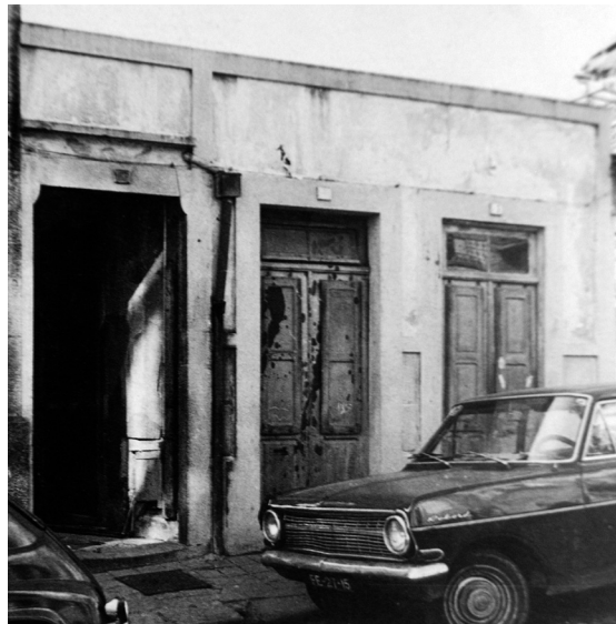
fig.48 [38] p.270 Fachada do lote n.º 113.
