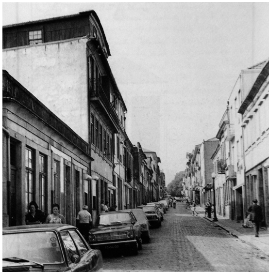
fig.47 [38] p.264 Vista Geral da rua de S. Victor.
