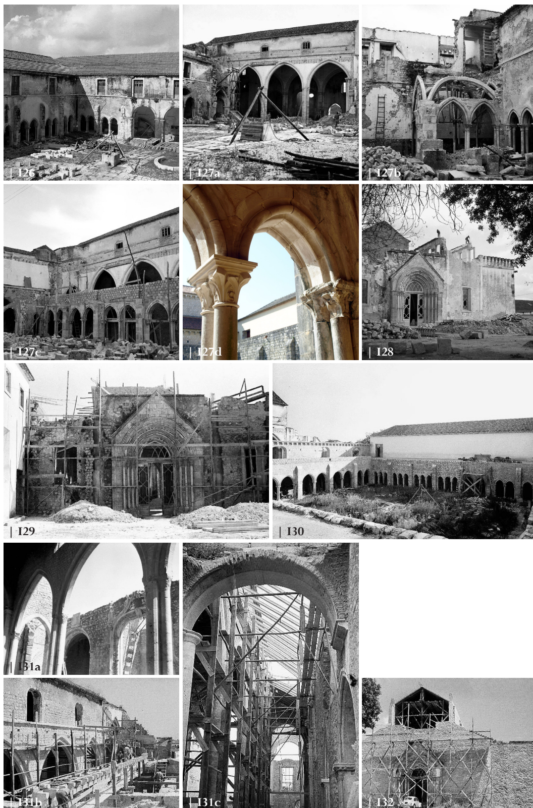
CSF | I26 Claustro com o 1º piso, 1955 | I27a Destruição da Galeria Sudeste do Claustro, 1954 | I27b Reconstrução de abóbada do Claustro, 1954 | I27c Claustro após reconstrução das abóbadas, 1955 | I27d Capitéis de colunelos, 2009 | I28 Demolição dos volumes da fachada principal da Igreja, 1955 | I29 Cofragem de pilares na fachada principal da Igreja, s/d | I30 Claustro sem as dependências do 1º piso, 1959 | I31a Nave lateral direita sem cobertura, 1969 | I31b Assentamento da cornija, 1969 | I31c Vigamento da cobertura da nave lateral direita da Igreja, 1969 | I32 Fachada principal da Igreja em fase de conclusão, 1974.
