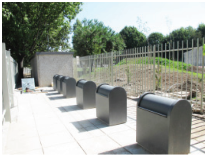
Figura 68 Posto de Transformação e R.S.U.
