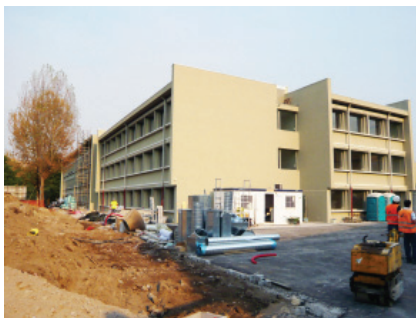
Figura 55 Vista sobre Bloco C
