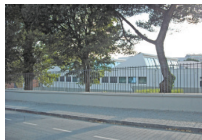
Figura 15 Escola Secundária Gonçalo Zarco, Matosinhos Cobertura em “shed” do corpo oficial
