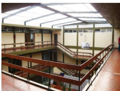
Figura 41 Vista interior do pátio central e escada
