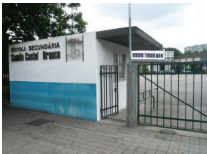
Figura 30 Portaria e entrada principal do recinto
