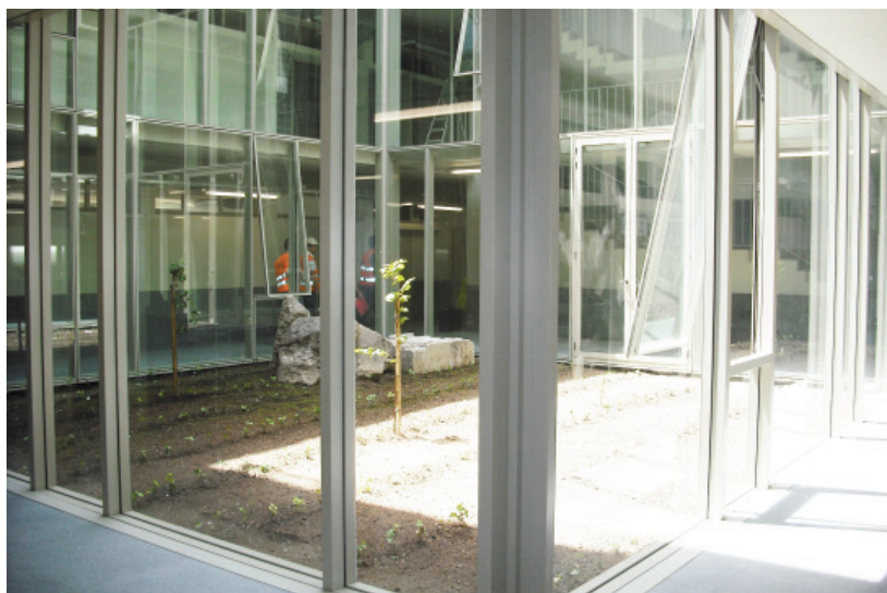
Figura 57 Vista sobre pátio central [piso 0]
