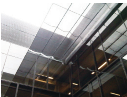
Figura 56 Dispositivo de ensombramento dos pátios centrais
