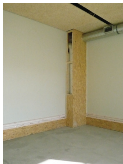
Figura 62 Rodapé e armário para condutas de ventilação
