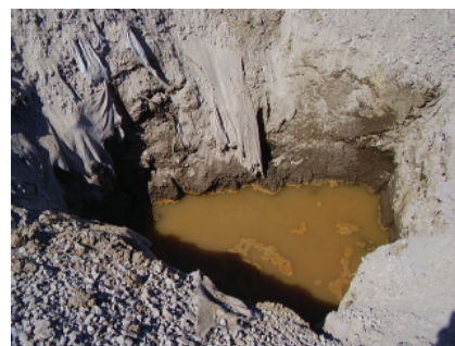
Figura 76 Sondagem do terreno
