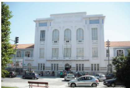
Figura 4 Escola Secundária Rodrigues de Freitas, Porto
