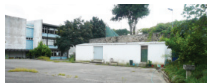
Figura 33 Oficina de manutenção
