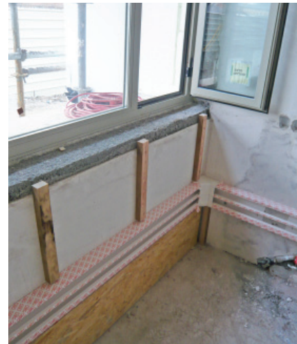
Figura 69 Construção de rodapé na parede de fachada Figura 70 Pormenor de rodapé adaptado à obra
