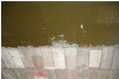
Figura 74 Confronto da laje existente com laje reconstruída
