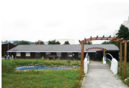
Figura 45 Ponte sobre lago artificial
