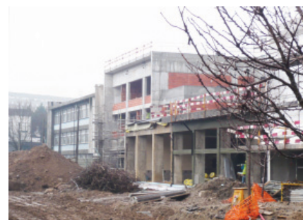
Figura 72 Bloco A sem estrutura do refeitório
