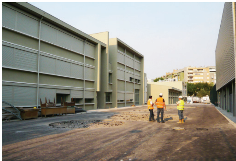
Figura 54 Vista sobre o Bloco A, B e Gimnodesportivo
