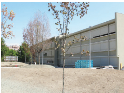
Figura 53 Vista sobre o Bloco C e novo edifício
