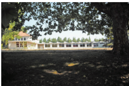
Figura 14 Escola Secundária D. Mário Sacramento, Aveiro Cobertura em “shed” do corpo oficial e corpo do ginásio
