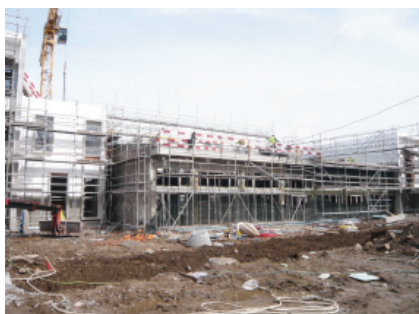
Figura 66 Vista sobre Bloco A
